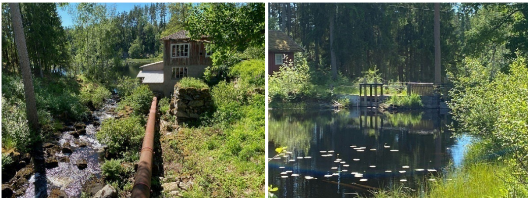
Figur 8. I vänster. Åboholms kraftstation med tub. Figur 9. Dammluckor vid Åboholms damm. Foto: Länsstyrelsen i Örebro län.
