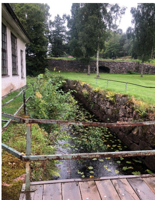
Figur 12. Stensatt vattenkanal från kraftverket. I bakgrunden syns dammvallen.
