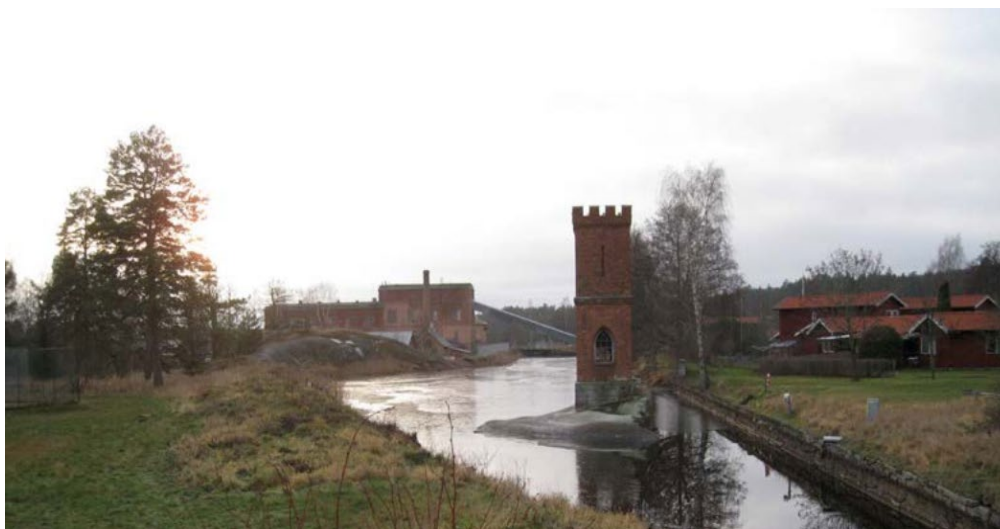
Figur 19. Vattentornet på en klippa i kanalen. I bakgrunden industribyggnader.
