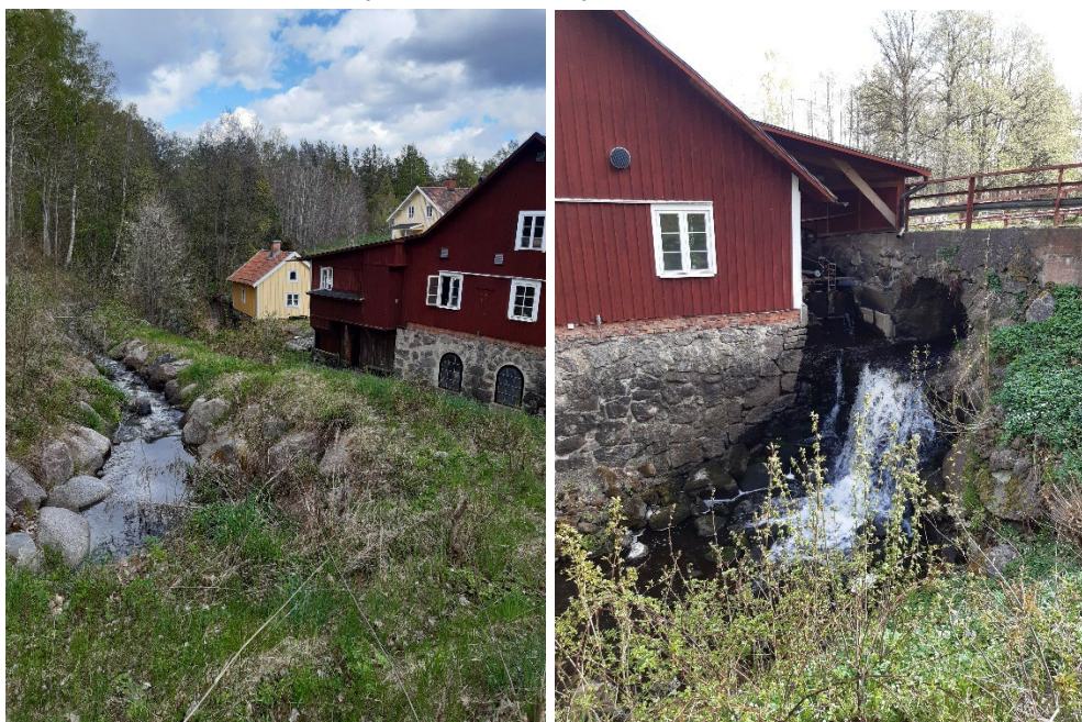
Figur 12. Stampens kvarn till höger i bild med omlöpet synligt till vänster. Foto: Länsstyrelsen 2022-05-12. Utloppet från Stampens kvarn och turbinerna. Dammen är belägen bakom gångbron som syns i bild. Foto: Länsstyrelsen 2022-05-12.
