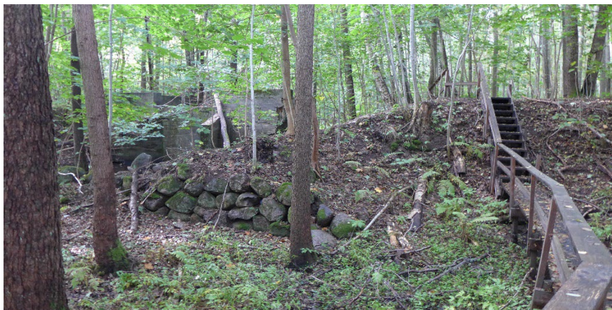
Figur 19. Vid Hammarens smedja finns två dammvallar. Konstruktion av betong, jord och sten. Två förmodade husgrunder och en led-arm i ån.
