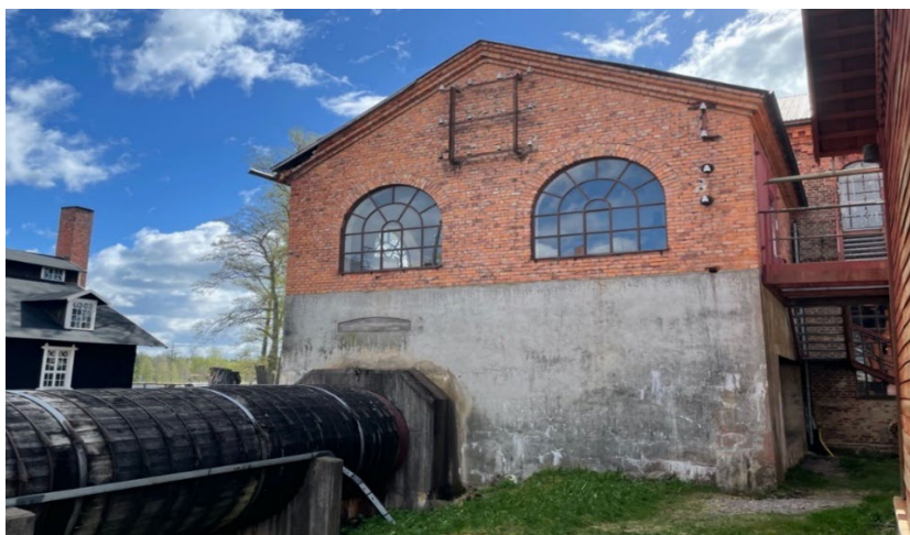
Figur 15. Kraftstationen vid Forsviks bruk.
