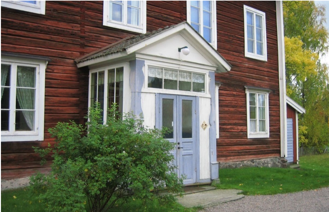
Figur 5. En förstuvist med svängda hörnstolpar på norra långsidan utgör huvudentré. Foto: Olle Lind, Länsstyrelsen i Dalarnas län.
