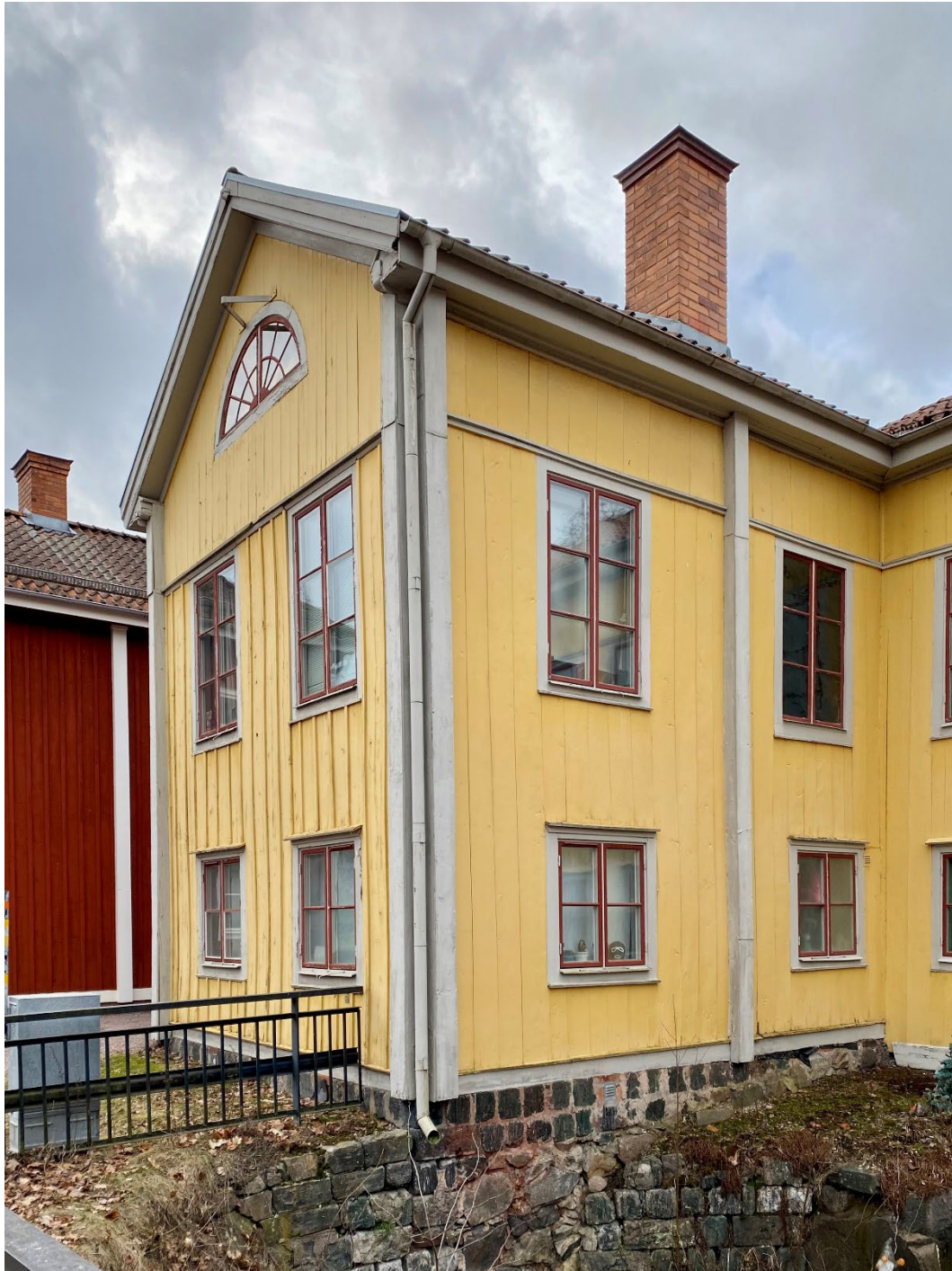
Figur 6. Huvudbyggnadens fasader som vetter mot Kyrkogatan och Avesta kyrka är klädda i panel och målade i ljusgult. Fasader mot gården lämnades med synlig timmerstomme. Notera slaggstensgrunden. Foto: Lovisa Lindberg, Länsstyrelsen i Dalarnas län.
