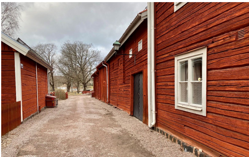
Figur 7. Huvugbyggnaden är ihopbyggd med uthusen. Från höger portlider och stall, skjul i resvirke och längst bort i bild magasin. Foto: Lovisa Lindberg, Länsstyrelsen i Dalarnas län.
