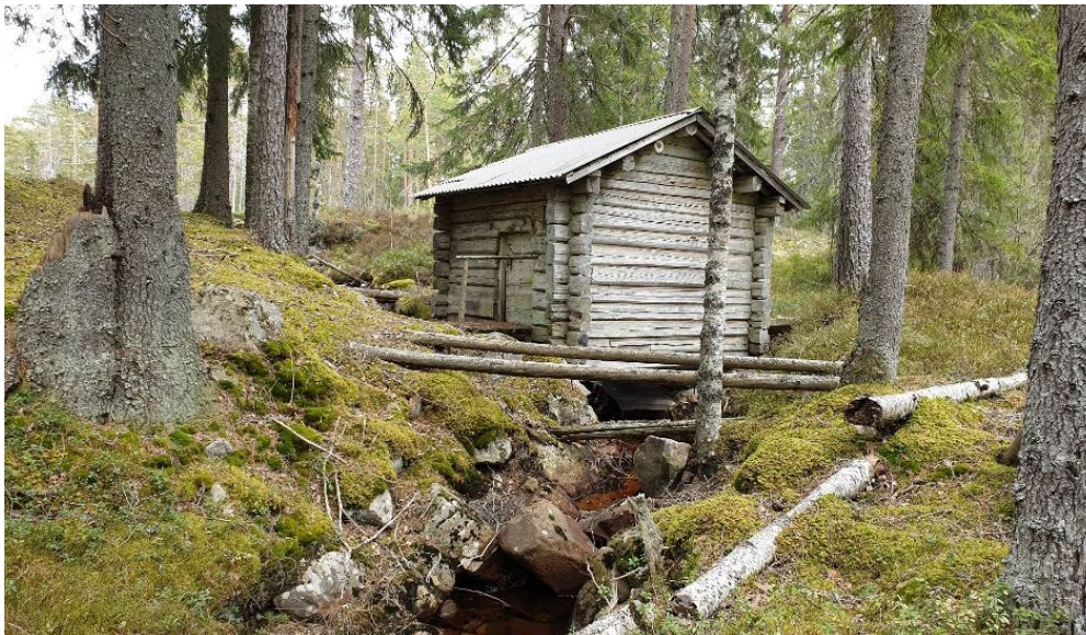
Figur 6. Exempel på tidig och småskalig vattenkraft i området. Foto på restaurerad skvaltkvarn, Krokkvarn. I bakgrunden skymtas tillhörande damm. Redovisad på karta från år 1821 (U21-1:6), men kan vara byggd år 1793 enligt uppgift från Finnmarkens hembygdsförening.
