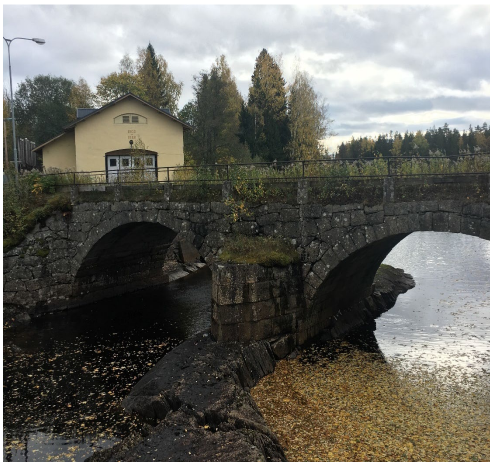
Figur 4. Hammarns kraftverk bakom stenvalvsbron.
