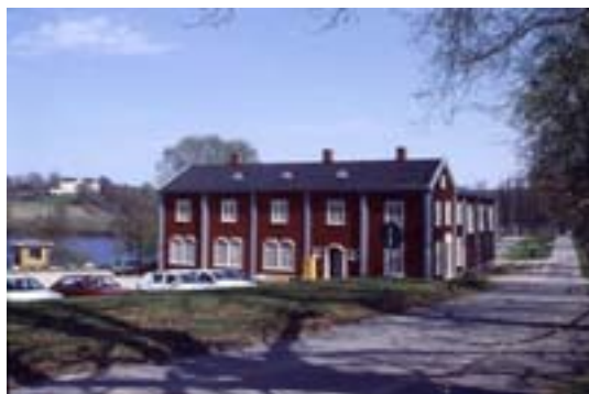
Till Byggnadsvård Nääs söker sig många som vill rusta kulturhistoriskt värdefull fastigheter. Foto: Ola Erikson, RMVG
