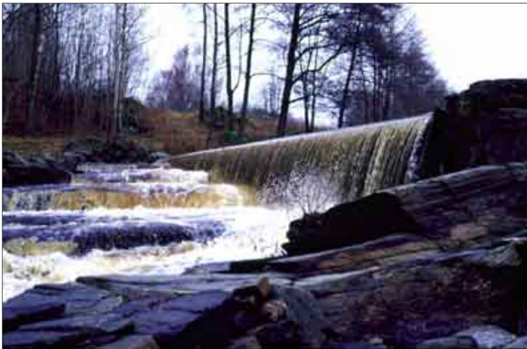
Fördämning vid Melltorp och Högens kvarn i Hyssna, Marks kommun. Här har en fisktrappa byggts om harmonierar med den omgivande kulturmiljön. Foto: Linnea Nordell
