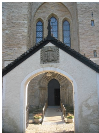
Kyrkporten flyttades till mitten av västgaveln i samband med De la Gardies ombyggnad av Varnhems kyrka. En dränering av marken runt kyrkan gjordes i samband med restaureringen av kyrkan på 1920-talet vilken medförde en nivåhöjning av porten. En tillfällig ramp har byggts vid kyrkporten.
