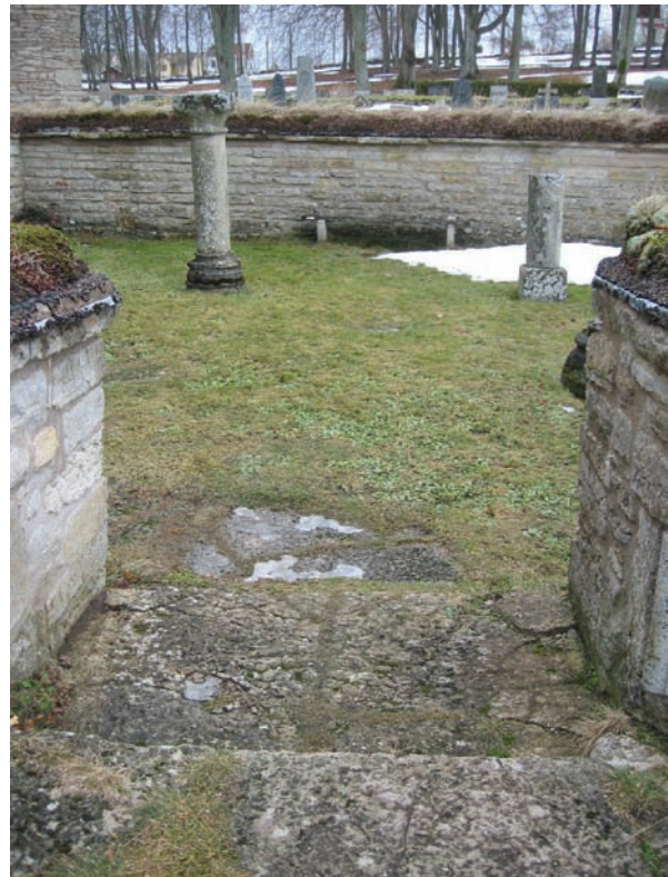
Klosterutrymmena ligger ett steg nedanför klostergången. En viktig antikvarisk frågeställning är om nivåskillnaden ska utjämnas med en reversibel eller permanent åtgärd.
