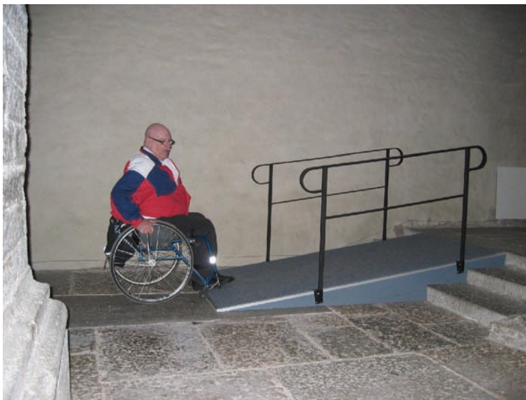
Tillfällig ramp i Varnhems kyrka. Rampen saknar avåkningskydd, räcken är för korta och rampen är för brant. I många fall är det bättre med en tillfällig lösning om det är svårt att enas om en permanent utformning. Tillgänglighetsbehoven ska dock vara tillgodosedda.
