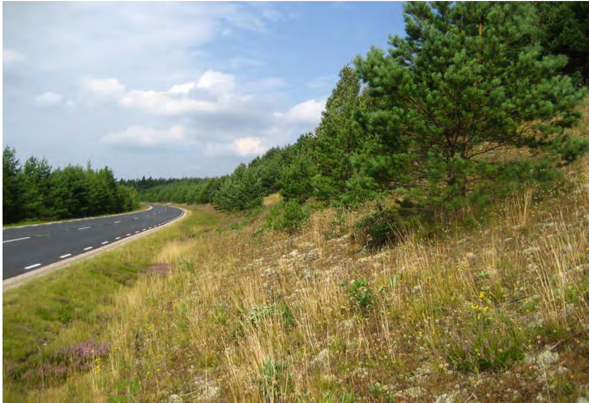
Lokal 33A. Kraftigt bevuxen sydvästvänd ca 900 m lång brant vägslänt N väg 167. Vy åt NV, 13 augusti 2007.
