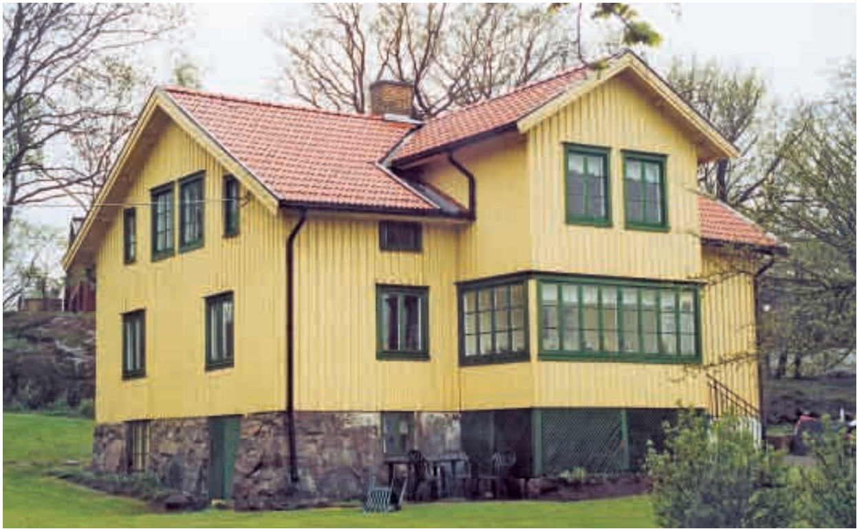
Bostadshusen på dubbel bredd utvecklades med tiden till högre byggnader med inredbar vind och ibland även hög stenfot med rymlig källare. Planlösningen var fyr- eller femdelad. Hustypen kom att kallas det västsvenska dubbelhuset. Askesby, Säve socken.
