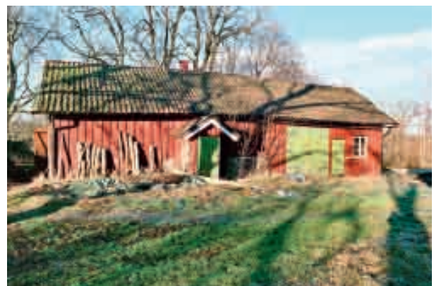
Övre bilden: Lillstuga och manhus. Mittersta bilden: Manhusets interiörer är välhållna med paneler och snickerier i ek- och mahognyådring. Nedre bilden: Den gamla ladugården innehåller idag bland annat höns hus, vedbod och mjölkällare.
