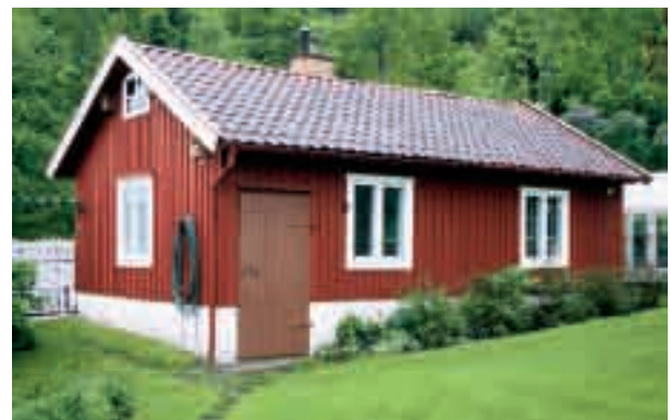
Överst: ladugårdslängan uppfördes i L-form, men byggdes på 1930-talet till med ytterligare en liten vinkeldel. Där- under bostadshuset, placerat tätt intill ladugårdslängans gavel, samt garage-, tvättstuge- och snickarbodsbyggnaden.
