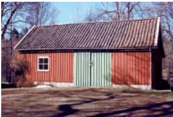
Ladugårdslänga, bostadshus och snickarstuga samlar sig kring gårdsplanen. Snickarstugan består av ett timrat snickarrum och ett förrådsrum i stolpkonstruktion.
