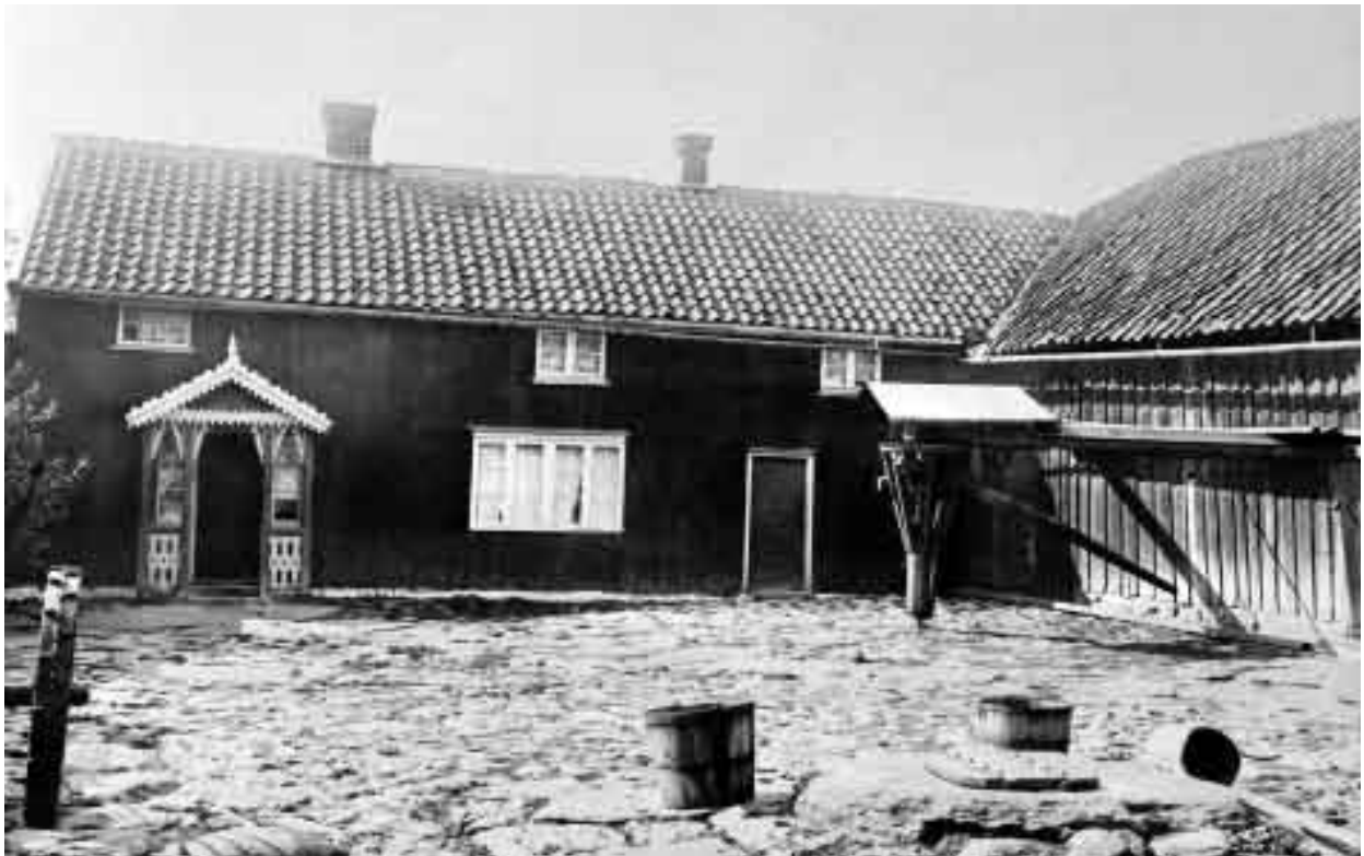
Kringbyggd gård med stensatt gårdsplan. Bostadshuset, en framkammarstuga, är här sammanbyggt med ladugården. Hästvandrigen att driva tröskverket med står uppställd på gårdsplanen, där också brunnen syns. Ranntorp, Lindome socken. Foto: Bohusläns museums arkiv.
