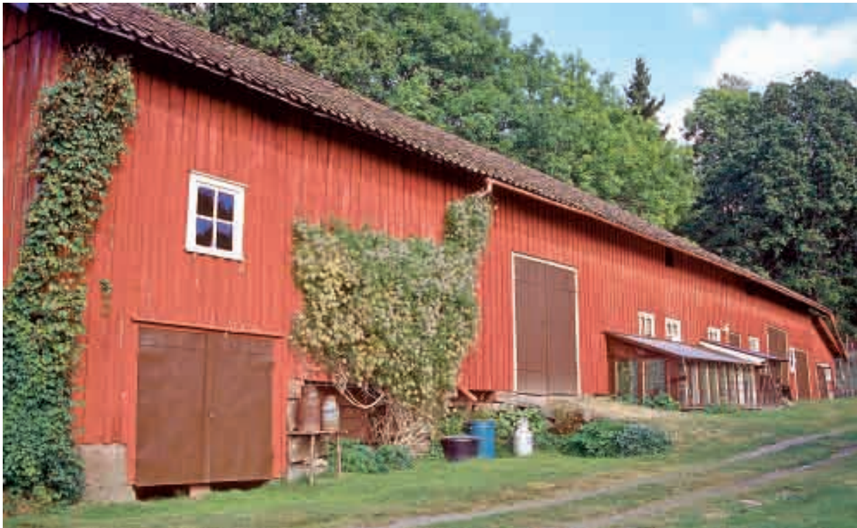
Ladugårdslänga från sekelskiftet 1900. Närmast i bild vagnbod, sedan parloge, fähus och stall.
