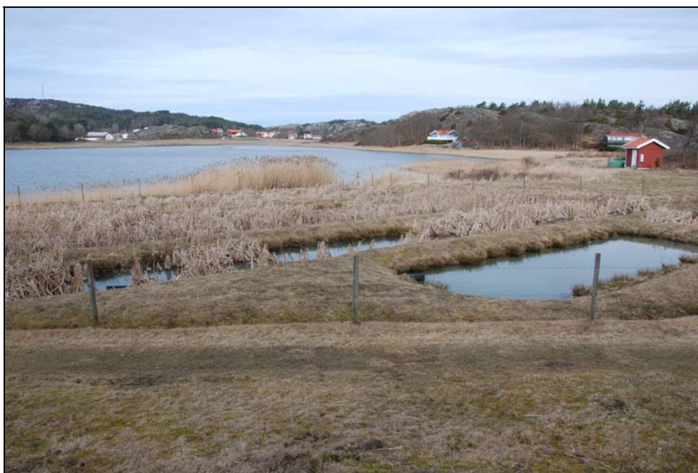
Olsby avloppsreningsverk (i högerkanten på bilden), på Tjörn, med efterföljande våtmark i form av levéer.
