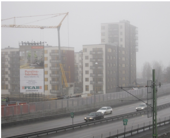
Figur 12: Foto av Lundbyleden i förgrunden framför Tingstadsvassen 34:1.
