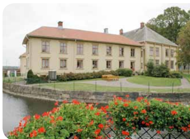
Vågmästaregården är en av flera gamla gårdar som finns bevarade runt Plantagen i Åmål och som har skyddats som byggnadsminne. I övrigt har mycket rivits i Åmål.
