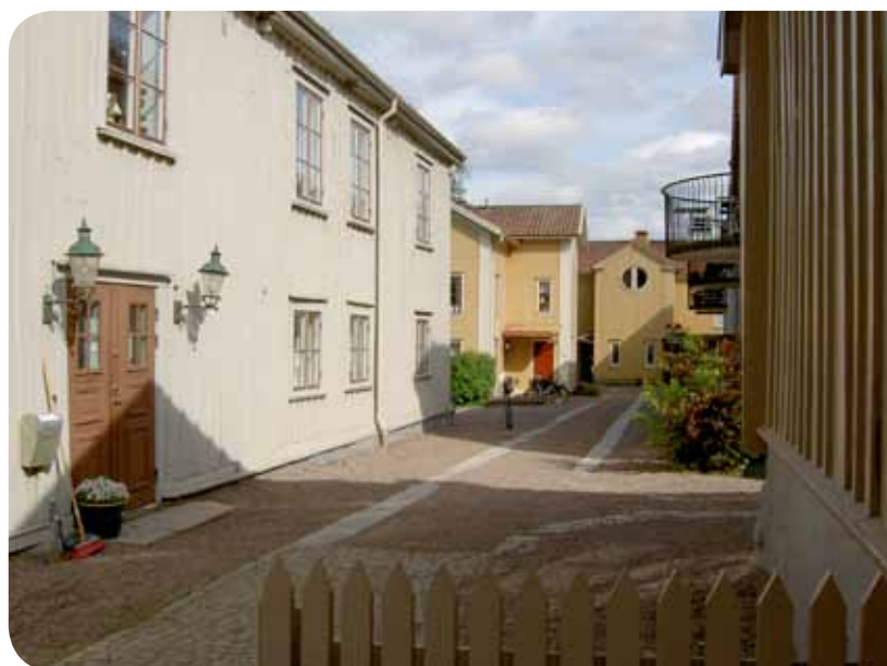
I Kvarteret Långan 1 har fastigheten både gamla bevarade byggnader och nya hus som anknyter till trästadens tradition i skala, färg och materialval.
