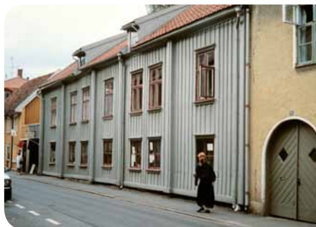
I centrala Alingsås finns en hel del äldre träbyggnader bevarade och flera är också skyddade som byggnadsminnen, däribland Brunos garvaregård i kvarteret Korpen.
