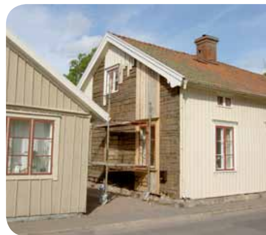
De gamla timmerhusen har oftast en gedigen stomme som blir synlig vid renovering. Med ett bra underhåll är de verkligen långsiktigt hållbara. Bild från Sjögatan i Hjo.
