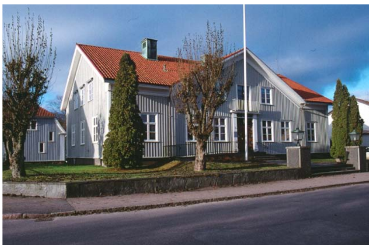
Tingshuset i Svenljunga uppfördes i slutet av 1850-talet för att fungera som domstolsbyggnad för Kinds härad. Idag fungerar det som bibliotek. Foto Eva Löfgren/Olinska stiftelsen
