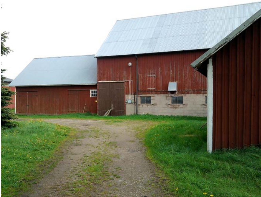
Överloppsbyggnader uppförda i mitten av 1900-talet. Foto: Mikael Hammerman
