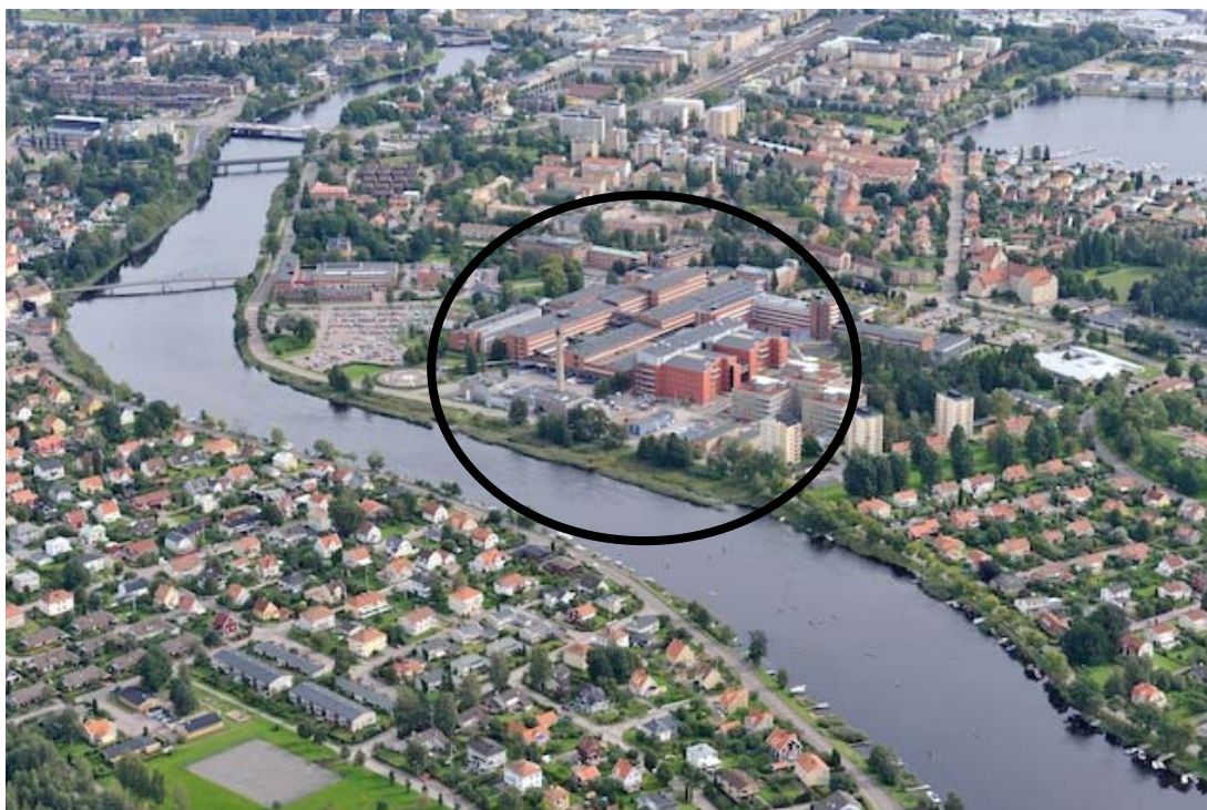
Bild 5: Centralsjukhuset och dess maskincentral (i bildens mitt) bedöms vara det allvarligaste riskobjektet i Karlstad. Foto: Mikael Svensson
