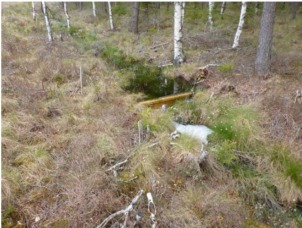
En dikespropp byggd av spontade 28 mm brädor i en utdikad våtmark. Denna typ av dikespropp är en billig lösning som kan användas i våtmarker där trädrötter och stenar saknas. De spontade brädorna som spetsas i nerändan slås ner med en slägga och binds ihop med en 45 * 45 mm regel i överkant varefter brädorna sågas av. Foto: Johan Andersson
