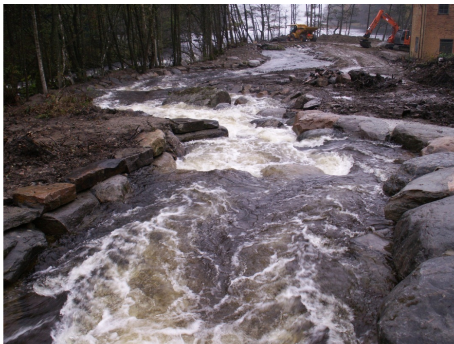
Omlöpet vid Ålgårda öppnades under oktober 2012. Förhoppningsvis kunde några laxar och havsöringar simma upp. Visst arbete med omlöpet kommer att genomföras under 2013 bl a förlängning av nedre delen samt tillverkning och installation av intagsluckor. Foto: Andreas Bäckstrand.
