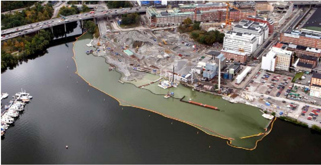
Bild 8: Siltgardin Hornsberg, Stockholm (källa: Tekomatic AB)
