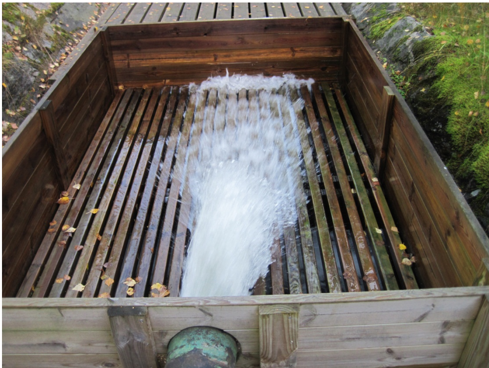
Figur 14. Lockvattnet påsläppt med fullt tryck för första gången efter reoveringen (foto sept. 2011).
