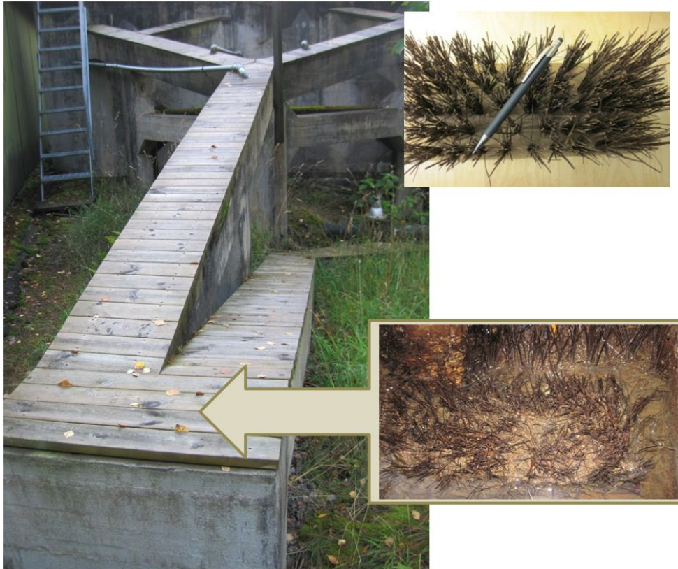
Figur 12. Fördelningen av uppvandrande ål sker via den träinklädda ledaren som delas upp till de fyra olika betongbassängerna vars vägg syns i fonden. Infällt: väl använt vandringsmedium, bestående av specialgjorda borstar. Övre bild: borste i nyskick (foto sept. 2013).
