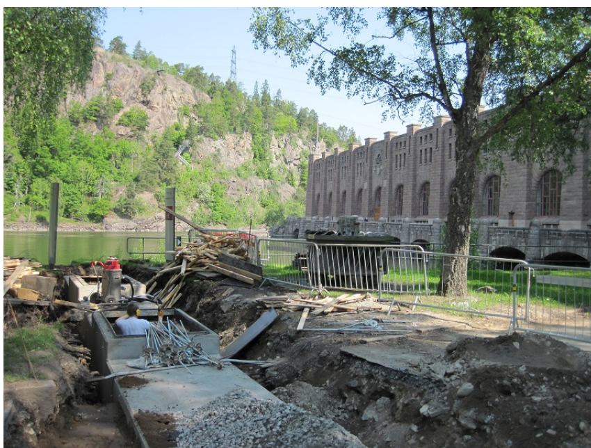
Figur 19. Bild från renoveringsarbetena med passagen av vägen fram till ålledarna nedanför kraftstationen just innan matarröret brast (foto maj 2011).
