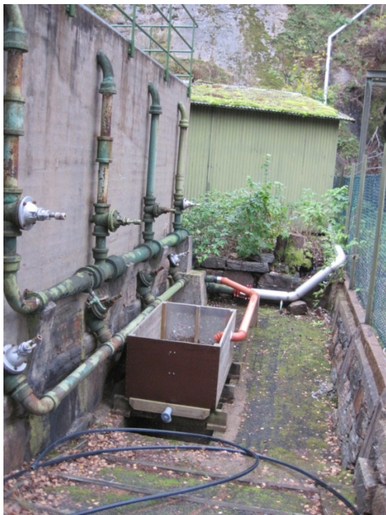
Figur 15. Anordningen för tömningen av de 4 samlingsbassängerna en i sänder ner i en såll-låda. Lockvattnet från kanalen ovanför slussarna kommer ner i det gråa röret i bildens övre högra hörn (foto sept. 2013).
