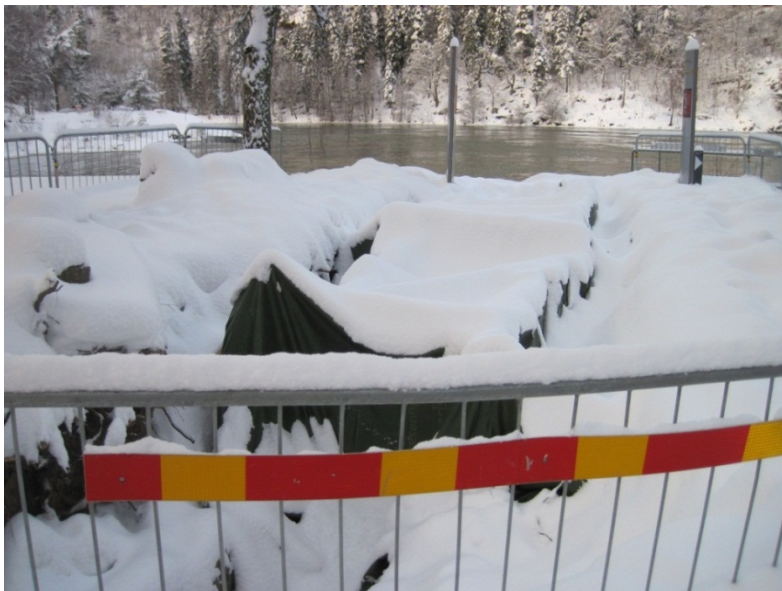
Figur 17 och Figur 18. Bilder från renoveringsarbetena under vintern med tidigt och rikligt snöfall (foto dec 2010).
