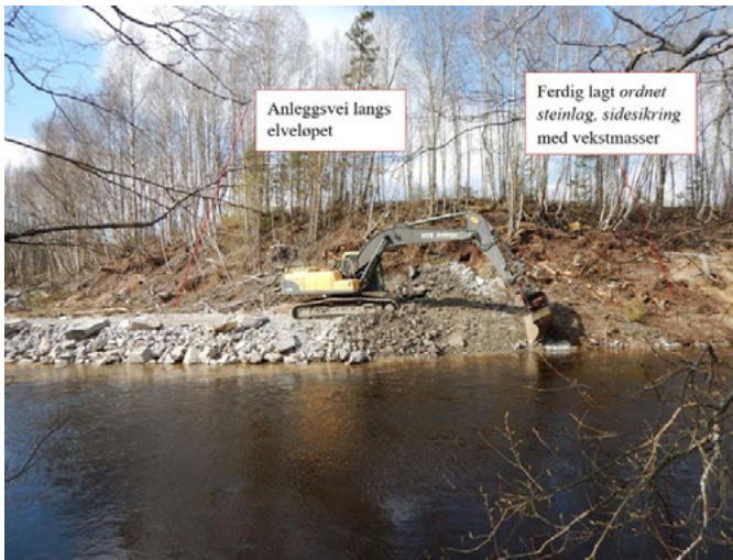
Figur 4: Grävmaskin i det slutliga arbetet.
