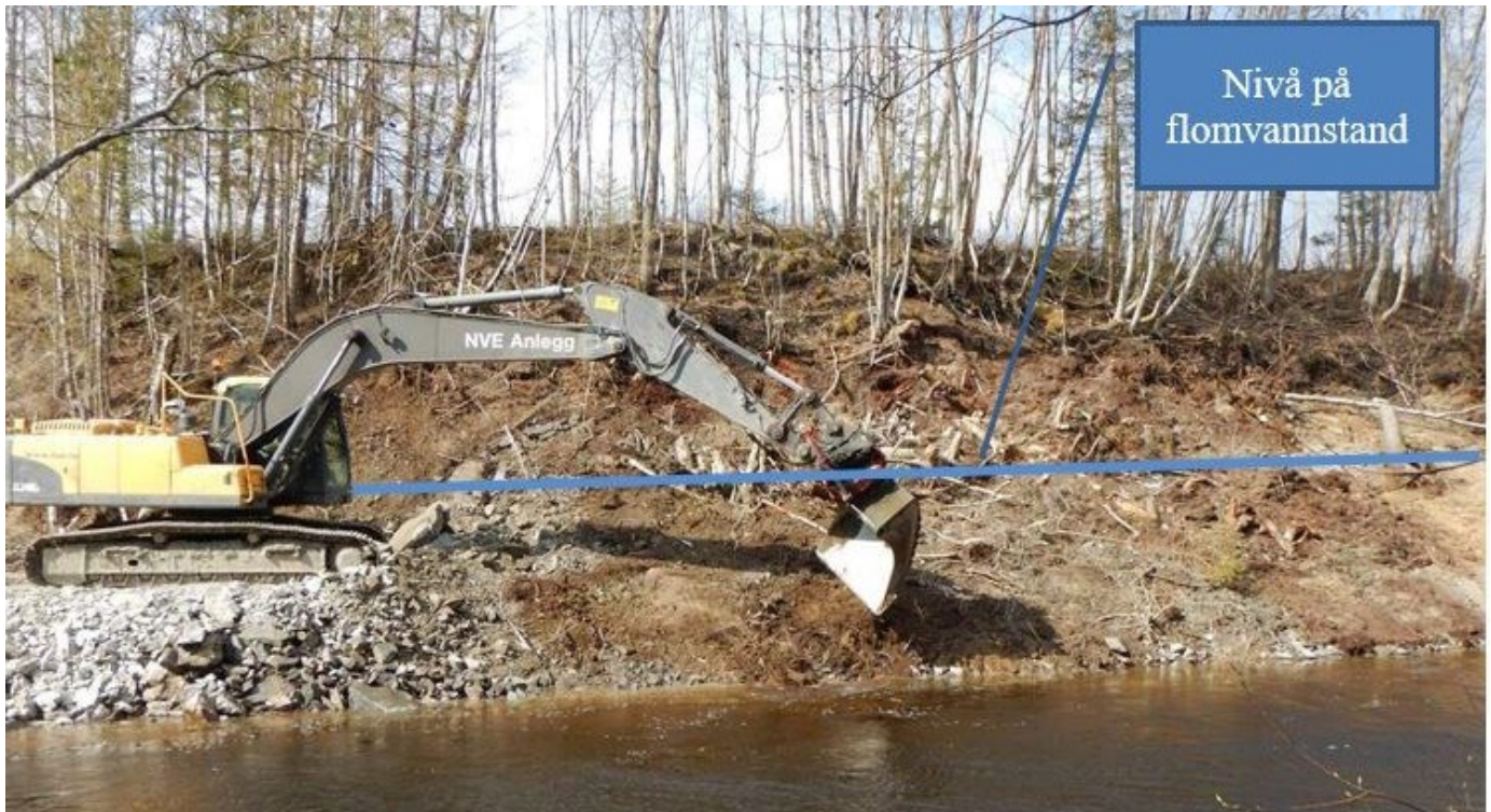
Figur 10. Vattennivån i bild visar det ungefärliga medelvattenstånd vid färdigställandet. Nivån på översvämningnivån visas med hjälp av den blå linjen i bilden, den är högre än byggvägen. (Foto: Geir B. Hagen, NVE).
