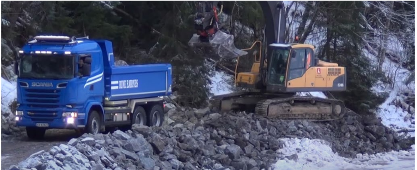
Figur 1. En lastbil backar på byggvägen och tippar stenar framför grävmaskinen.
