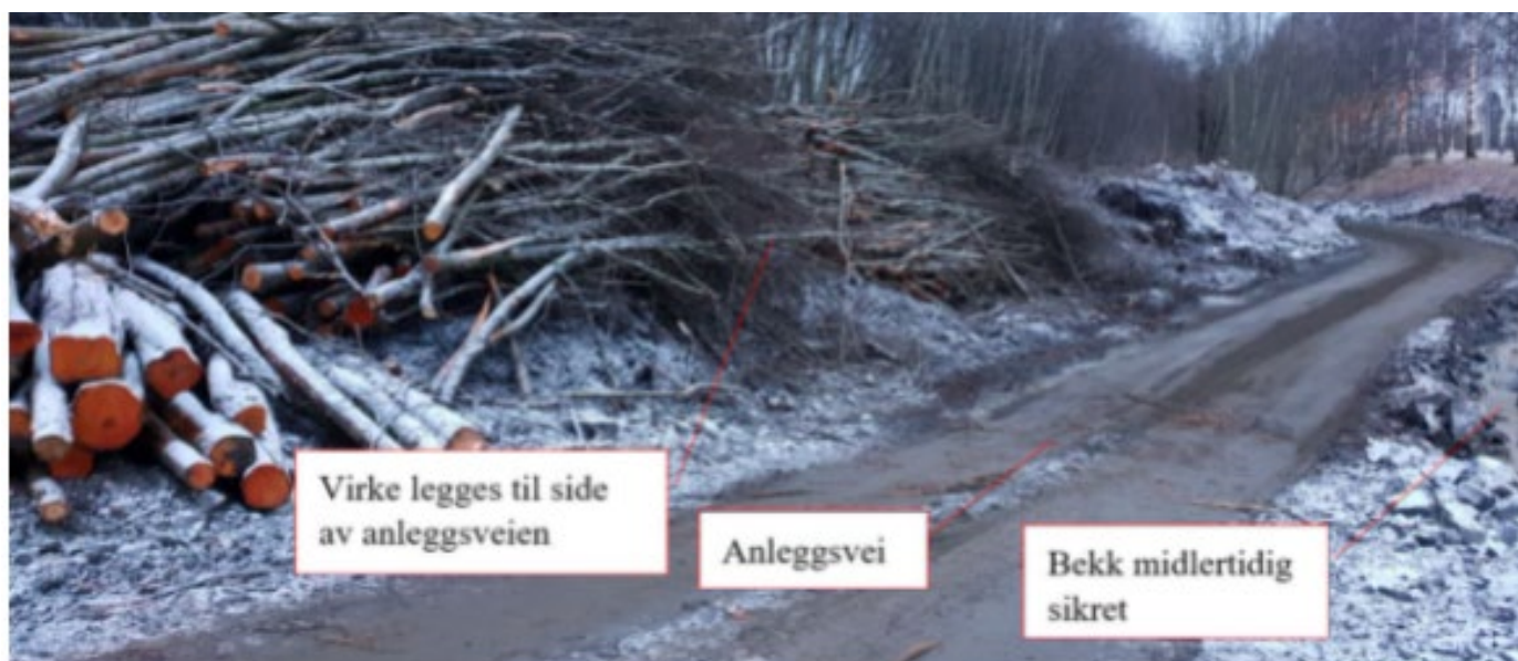
Figur 8. Skogsrøjning langs Brokskitbækken ved Stiklestad. Samma princip gæller vid større vattendrag Foto: Roar Gartland, NVE.
