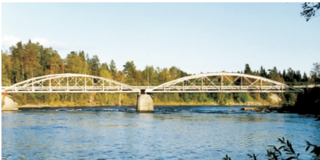
Fackverksbro av stål över Öre älv i Nordmalings kommun. Bron byggdes 1911 och stålfackverket levererades av Bergsunds Mekaniska verkstad i Stockholm. Foto: Andreas Grabn.
