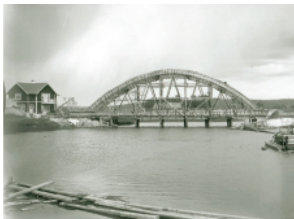
Betongbågbro i Gamla Falmark, Skellefteå, under byggandet på 1930-talet. Foto: Västerbottens Museums fotoarkiv.
