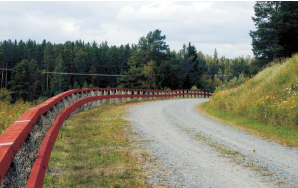
I byn Bränna, Vilhelmina kommun, finns ett 168 m långt vägräcke med stengardister, navföljare och toppliggare av trä. Räckets restaurerades år 2000. Foto: Jeanette Joelsson.
