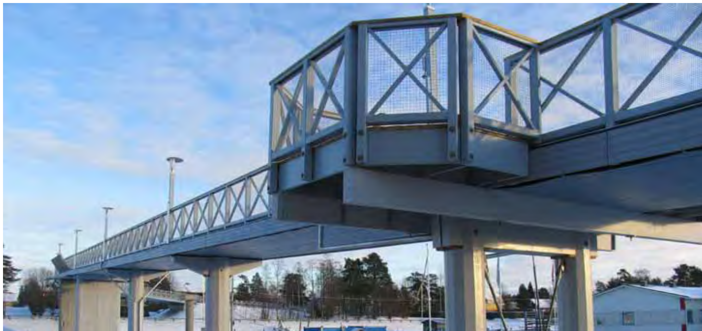
Del av 230 meter lång träbro vid Strömpilen i Umeå med ihåliga Comwoodpelare, levererad av Martinsons 2006.
