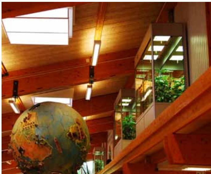
Ljuslanterniner och biologiska filter på GreenZone i Umeå.
