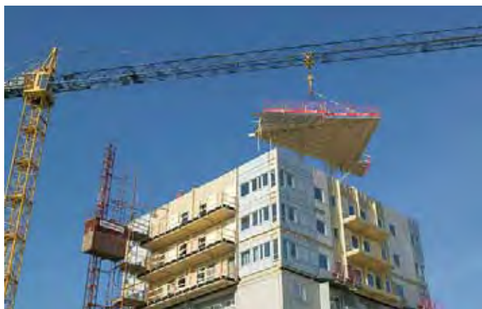
Påbyggnadsprojektet i kv Plogen Umeå 2004. Foto: Martinsons.
