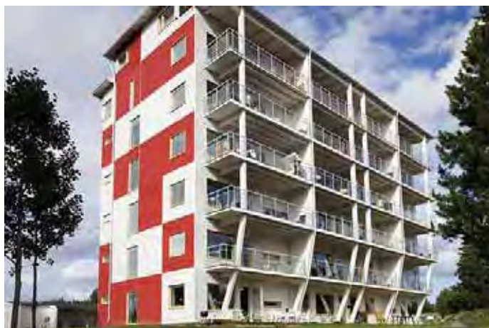
Trähus på Älvsbacka Strand i Skellefteå. Foto: Martinsons Byggsystem.
