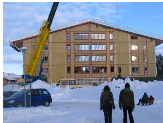
NYAB:s kretsloppshus under uppförande
