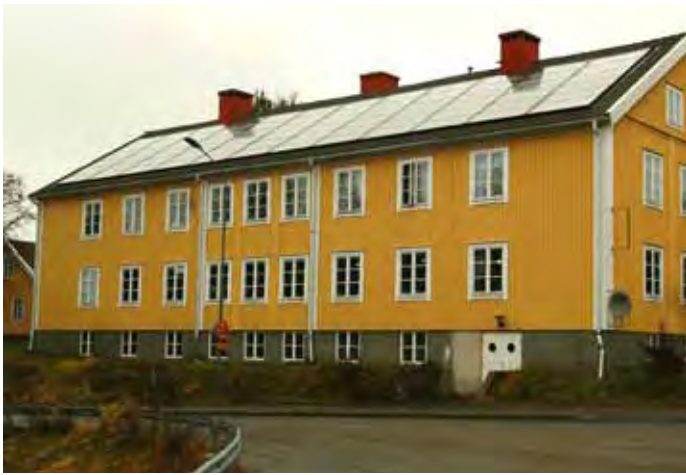
Flerbostadshus i Flurmark med solvärmesystem.
