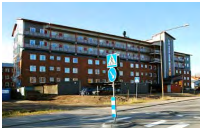
Lillbergets hyreshus vid Tegsvägen i Umeå, har höjts med två våningar.
