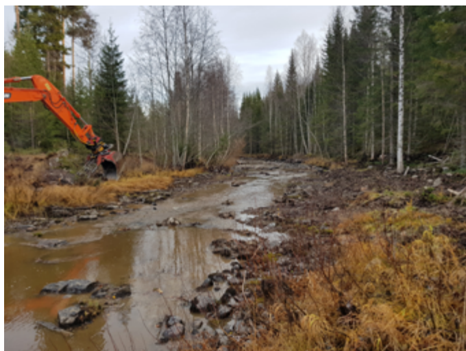
Pågående återställning av flottledsrensad fors i Mjösjöån (till vänster) samt färdigt resultat (till höger).
