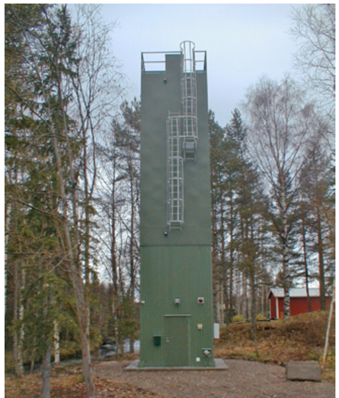
Kalkdoseren i Tvärån (Åby älv) nyttjas även för att höja pH i Åbyälven. Flödet i målpunkterna i Åbyälven är 17-18 gånger högre än vid doseraren. Även om en mycket hög kalkdos ( > 20 \text{ g/m}^3 ) nyttjas vid doseraren blir tillskottet av alkalinitet i Åbyälven tidvis för litet.
