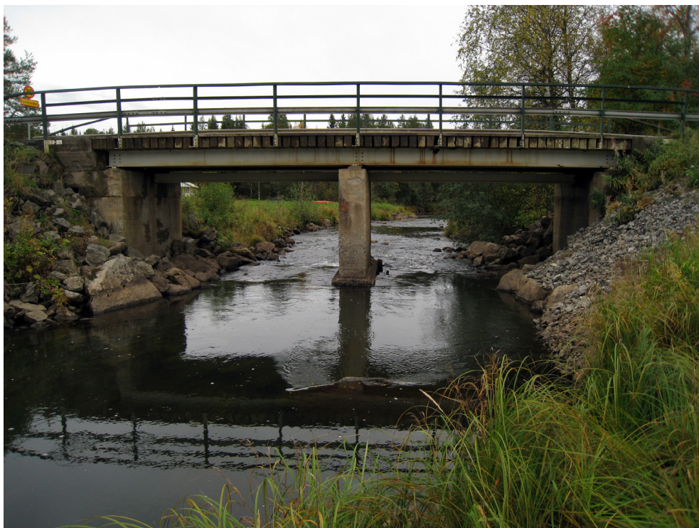
Bild 1. Exempel på inventeringslokal. Stränder och stenar på båda sidor under bron ger goda förutsättningar för uttern att lämna markeringar.
