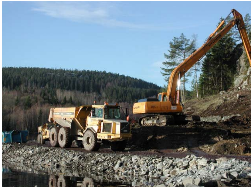
Pågående sanering av kisaska på Svanö, 2006-11-08. Fotograf: Karin Sjölund, Länsstyrelsen
