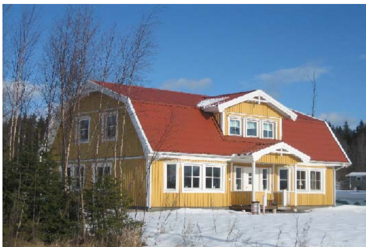
Foto: Nybyggnad, Alnö
