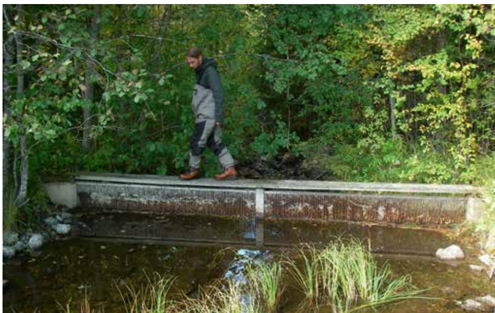
Figur 30. Fiskgaller är medvetet anlagda vandringshinder som har till uppgift att stänga in utplanterad fisk i sjöar.
