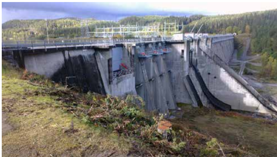
Foto 10. Ramsele kraftverks reglerdamm
