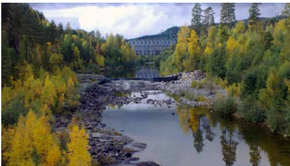
Foto 12. Spegeldamm nedströms Ramsele kraftverks reglerdamm.
