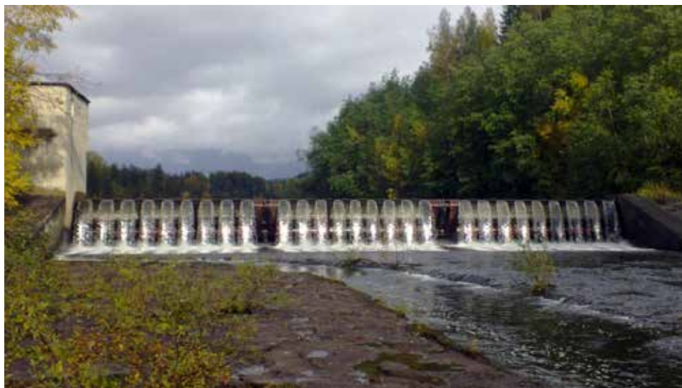
Foto 14. Reglerdammen i Vangforsen vid Holme By.
