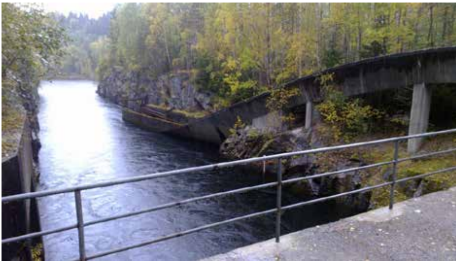
Foto 9. Edsele kraftverksutlopp till Faxälven. Till höger syns flottledsrännan.
