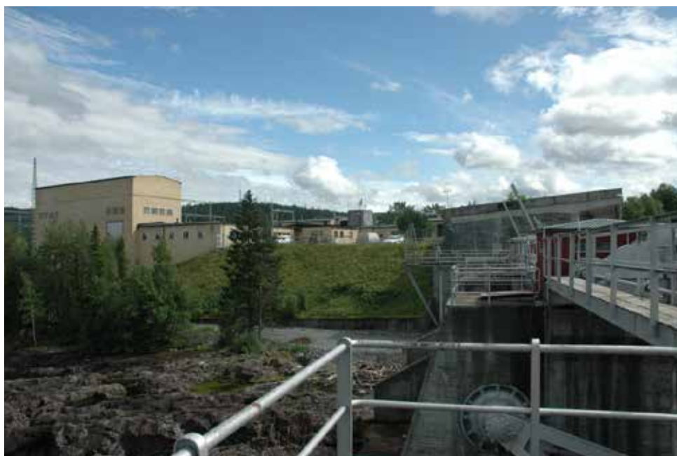
Foto 2. Hjalta kraftverks intagsdamm med kraftverket i bakgrunden och naturfåran till vänster om dammen. Foto: E.ON
