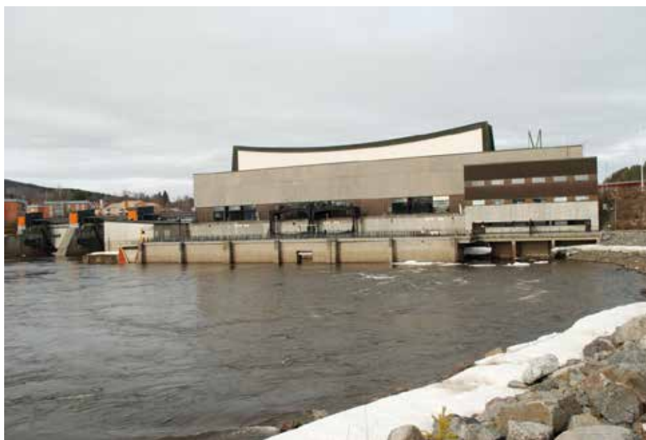
Foto 1. Sollefteå kraftverks intagsdamm. Foto. E.ON
