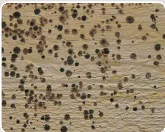
Svartmögel på fasad, Foto: MYCOTEAM
