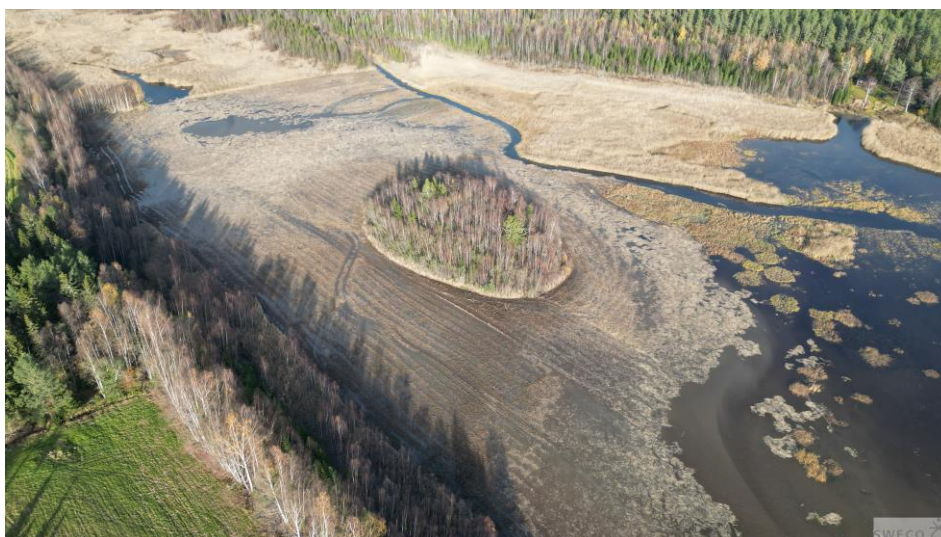
Figur 13. Drönarfoto efter genomförda åtgärder.
