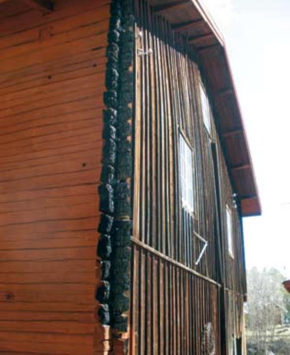
Kvamen har en gång brunnit. "Det brinner i knutarna" har hänt i verkligheten.
