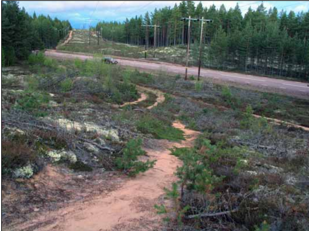
BON5. Kraftledningsgata N vägen till Älvdalen. Foto: Johan Abenius
