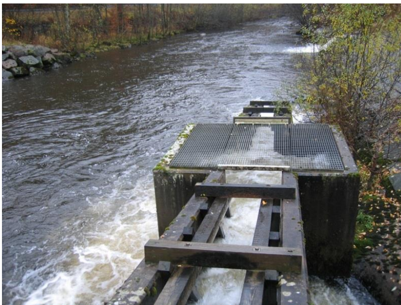
Bild 2. Jonsereds övre fiskväg, en denilränna, erbjuder fisken en vandringsväg förbi dammen som utgör ett definitivt vandringshinder mellan naturfåran vid Jonsereds kraftverk och sjön Aspen. I fiskvägen finns sedan 2005 en automatisk fiskräknare installerad. Foto: Länsstyrelsen i Västra Götaland.
