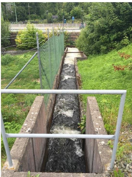
Bild 3. Jonsereds nedre fiskväg, en 100 meter lång kombination av kammarrappa och denilränna. Foto: Länsstyrelsen i Västra Götaland.
