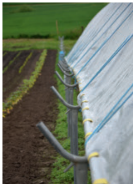
Stålörsbena nerborrade i marken. Längst upp är det en klyka som man monterar bågarna på.
