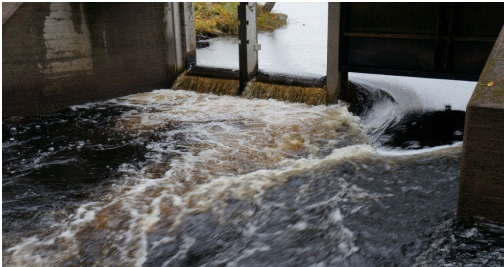
Bild 2. En lucka helt öppen vid östra utskovet. Vattennivån i Öjen är 0,2 m under dämningsskänken. Foto: DVF
