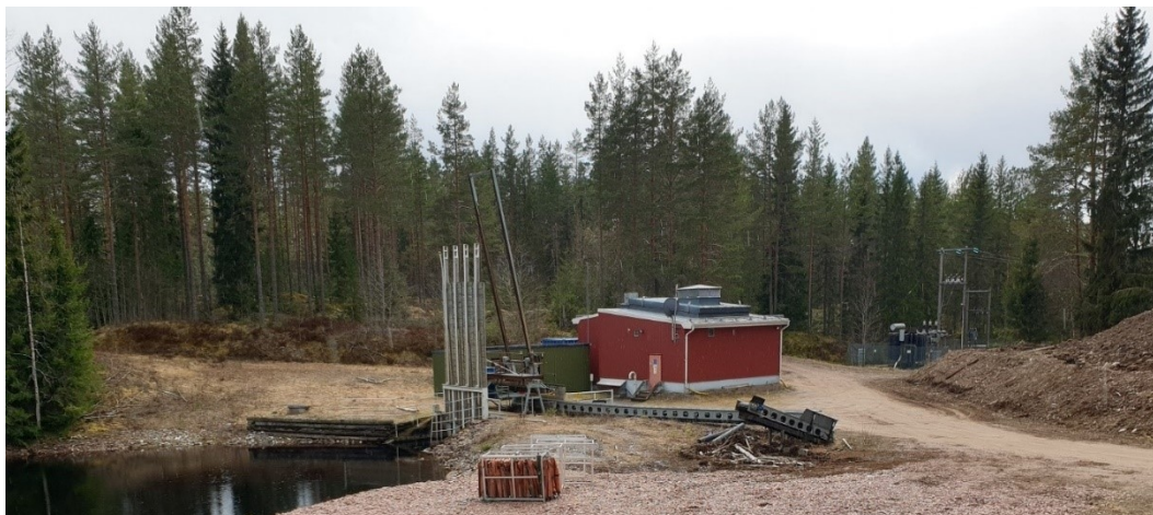
Figur 6 Kraftverksanläggningen vid Lisjön, Tystupet. Runt anläggningen och i skogen är stora massor med torv. Foto åt S.
