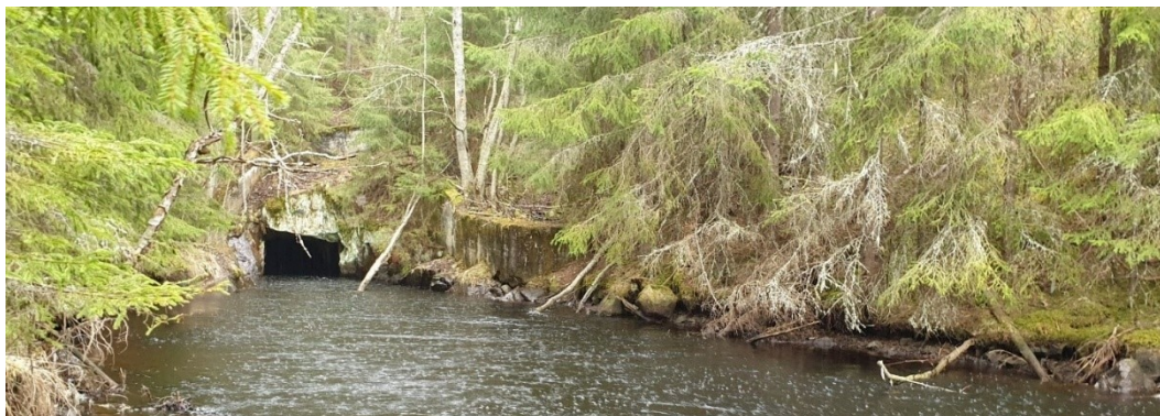
Figur 7 Utloppskanalen, cirka 1 kilometer väst om anläggningen. Foto åt Ö.
