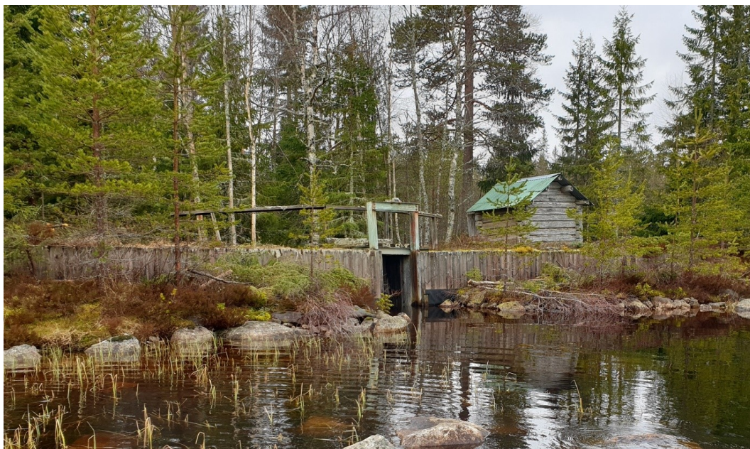
Figur 4 Damm samt dammvaktarkoja vid Holmsjön. Foto åt SV.
