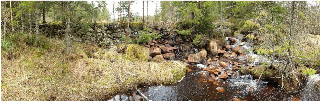
Figur 7 Panoramafoto av Djupdalsdammen (L2022:2880). Foto åt N.
