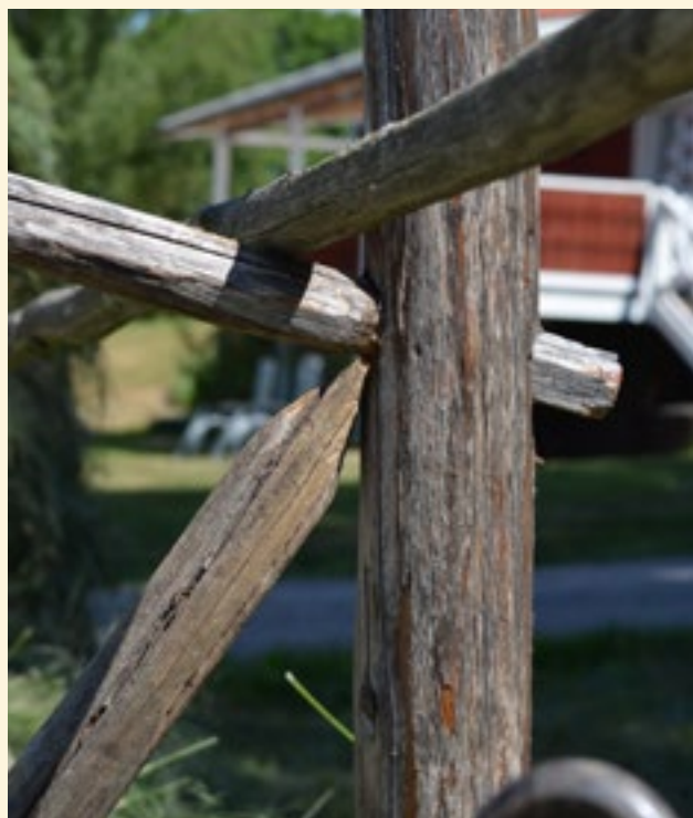
Det v-formade stödet stöttar under krakpinnen.
