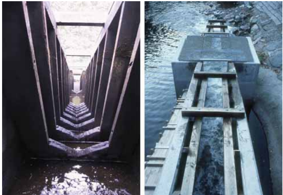
Figur 5. Exempel på en teknisk fiskväg i form av en s.k. motströmsränna från Hertings kraftverk vid Ätran (vänster) och Jonsereds kraftverk vid Sävån (höger). Bilden till vänster visar bromslamellerna inne i stigrännan. Bilden till höger visar två stigrännor med en mellanliggande vilobassäng.
