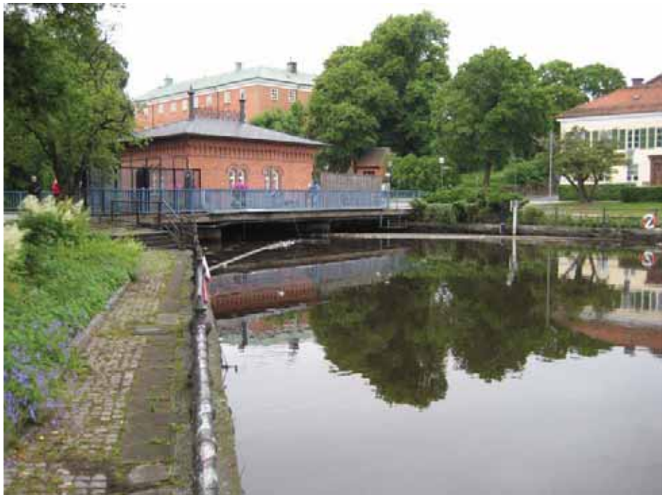
Figur 7. Slottsbron med Västerås kraftverks dammbyggnad och kraftstation på Svartåns högra sida. I bakgrunden skymtar Västerås slott. Vy från uppströmsidan mot söder.
