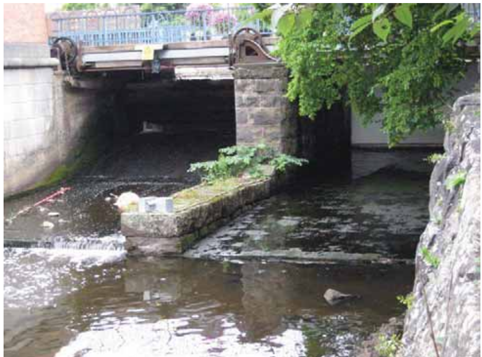
Figur 9. Utskov med skibordslucka till vänster och flodlucka till höger i bilden vid dammbyggnaden till Västerås kraftverk.
