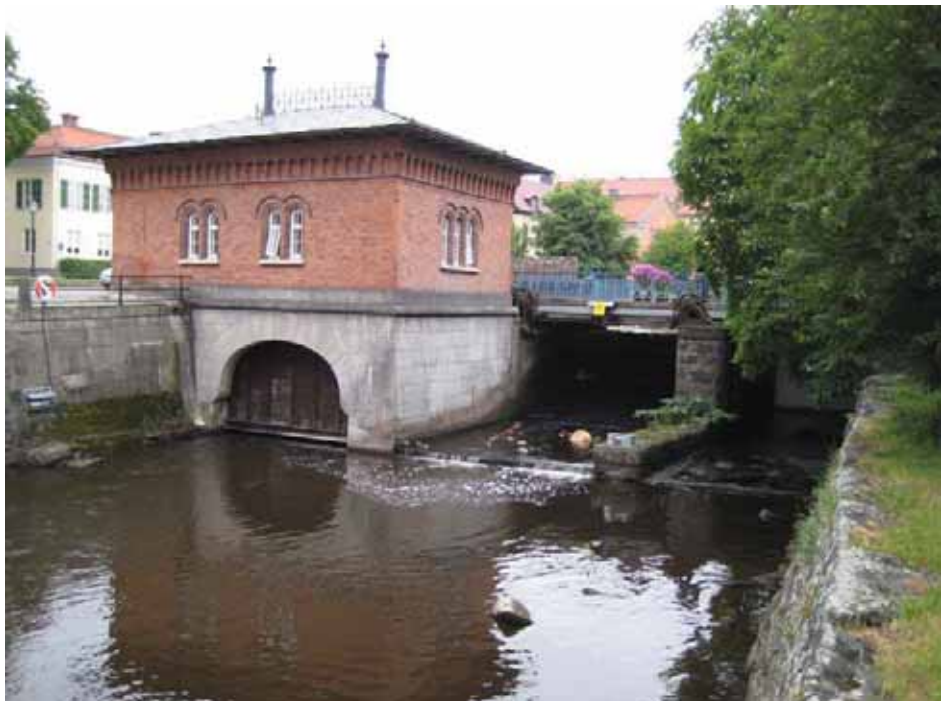
Figur 8. Västerås kraftverk med dammbyggnad och kraftstation på Svartåns högra sida. Vy från nedströmsidan mot nordväst.
