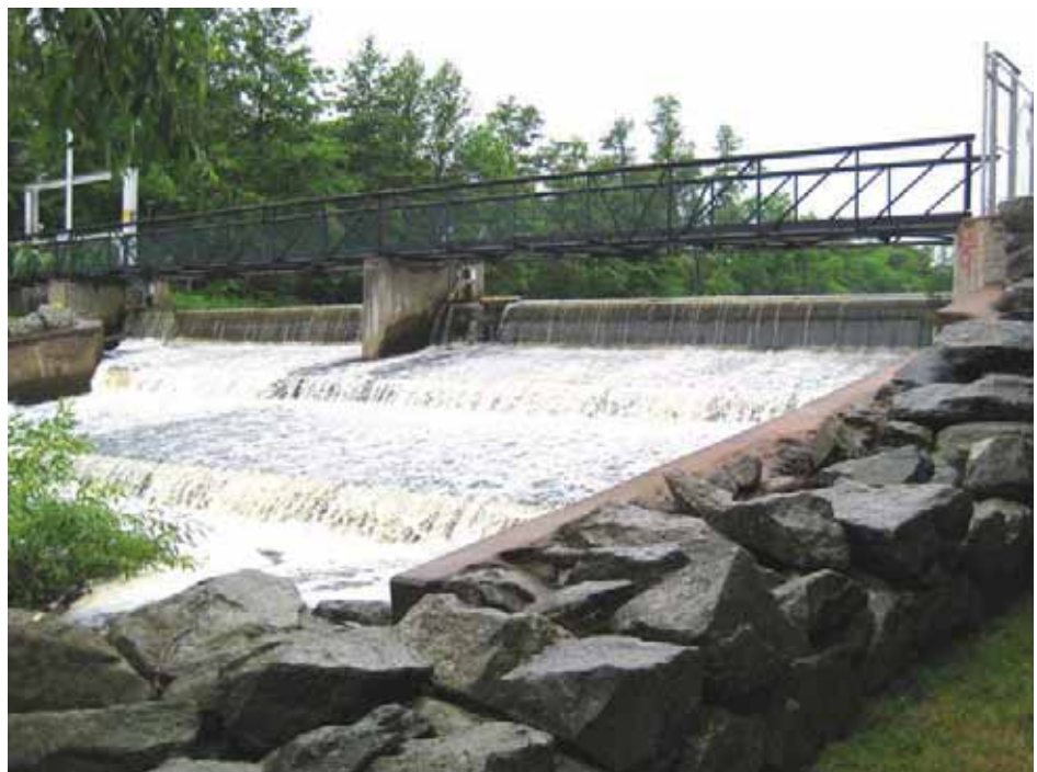
Figur 18. Dammbyggnad vid Västerås kvarn med två skibordsluckor till höger i bild och övre delen av flodluckan till vänster i bild. Vy från nedströmssidan mot väster.
