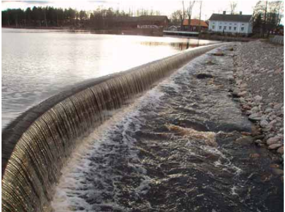
Figur 4. Exempel på en nyanlag naturliknande fiskväg i form av ett, s.k. inlöp, från Hilleviks bruksdamm vid Björkån.
