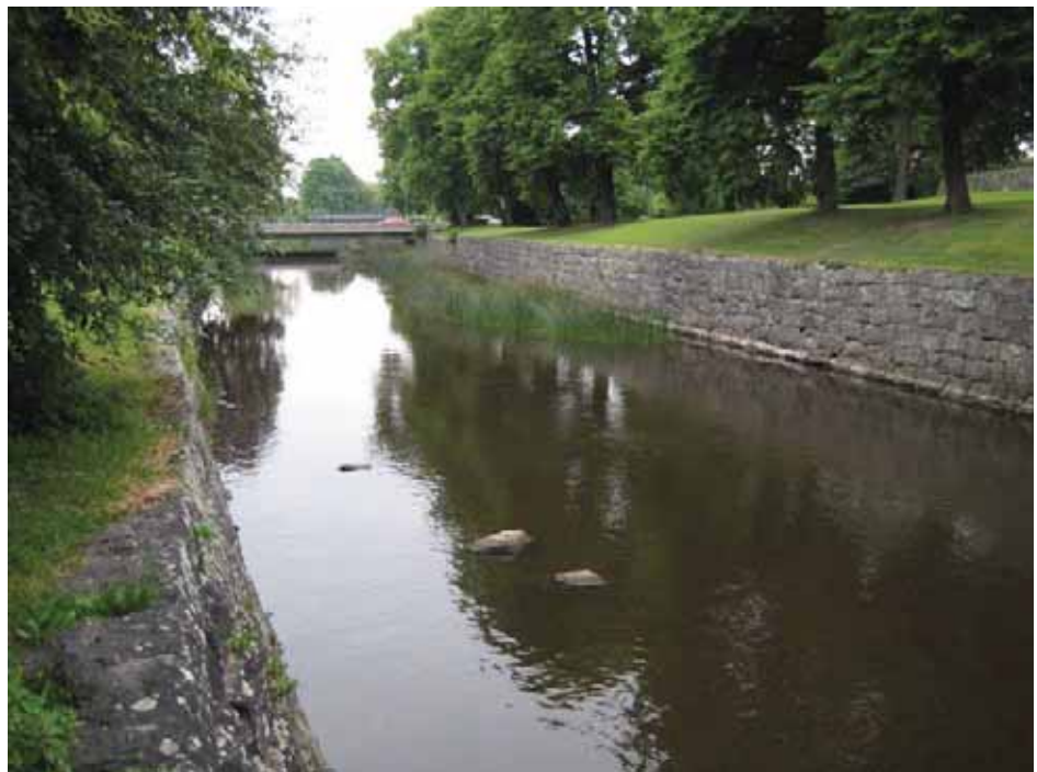
Figur 12. Stenmurar längs Svartåns stränder nedan Västerås kraftverk. Vy från Slottsbron mot söder.
