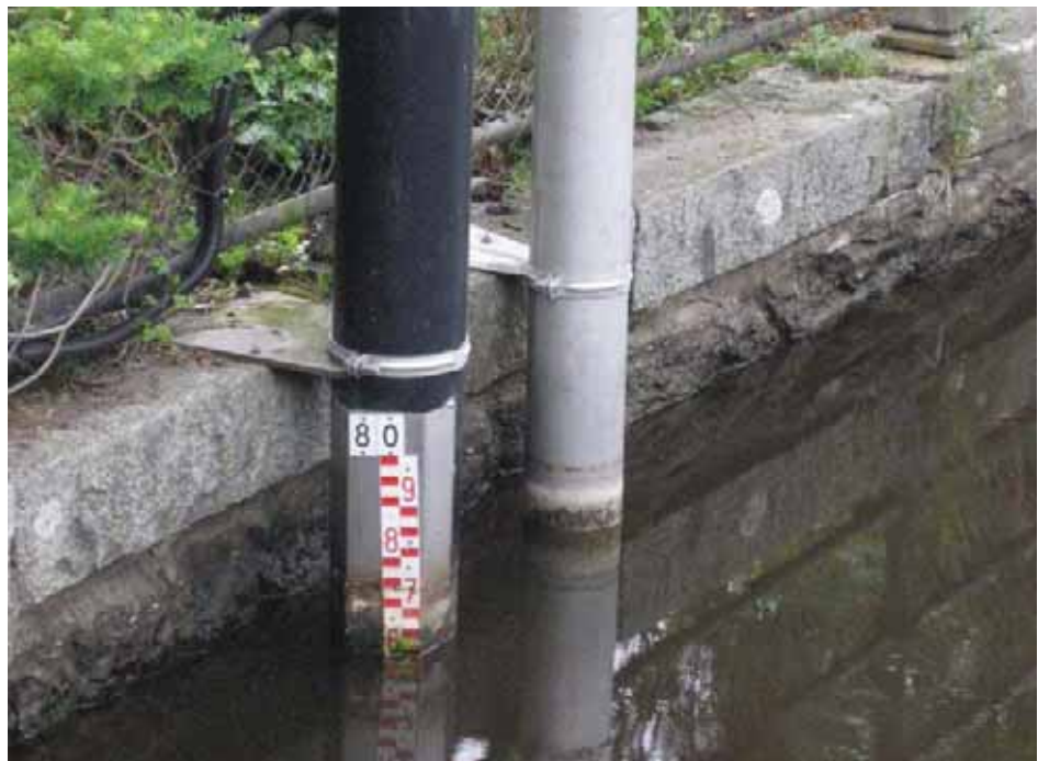
Figur11. Pegel för avläsning av vattenståndet i det indämda vattenområdet ovan Västerås kraftverk. Vy från Slottsbron mot nordväst.
