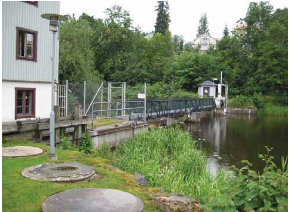
Figur 17. Dammbyggnad och f.d. intagsöppning till det sedan länge nedlagda kraftverket vid Västerås kvarn. Vy från uppströmssidan mot söder.
