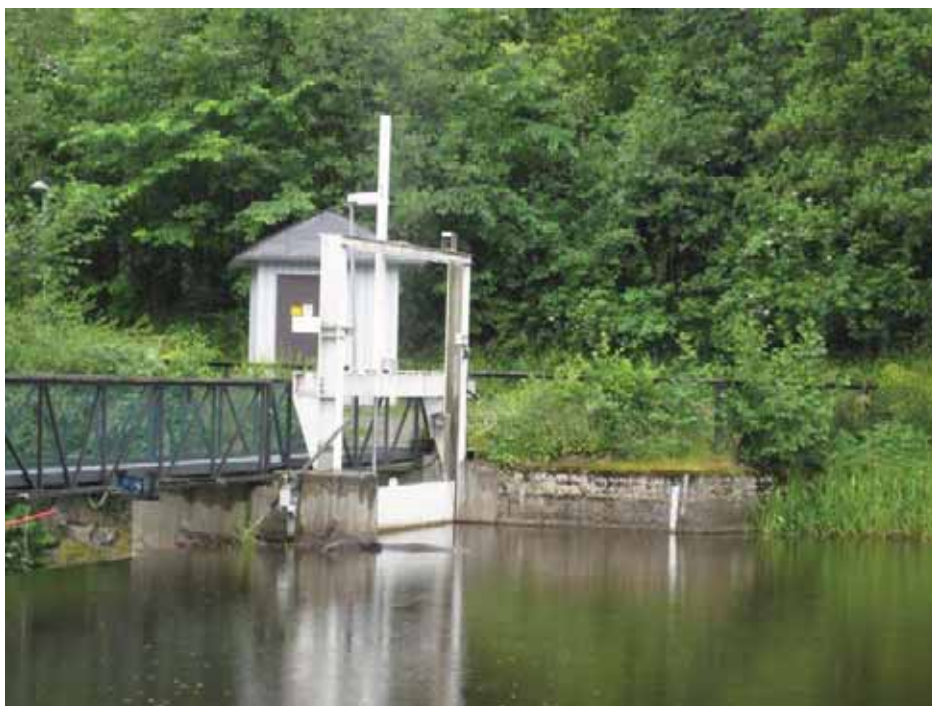
Figur 20. Dammbyggnadens högra landsfäste med flodlucka och pegel. Vy från uppströmssidan mot sydväst.
