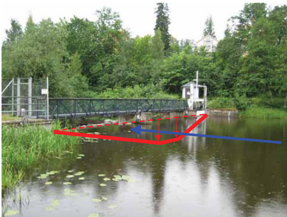
Figur 22. Föreslagen sänkning av dammbyggnadens tröskel och utrivning av luckor för återställning av åfåran Västerås kvarn. Dammens båda landfästen bevaras orörda. Vy från åns vänstra strand mot söder.
