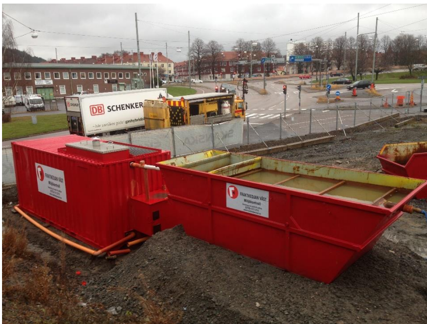
Figur 3.1. Fackcontainer med partikel/slamavskiljning till höger med en påkopplad oljeavskiljare inrymd i containern till vänster. Foto. A-C. S. Lember
