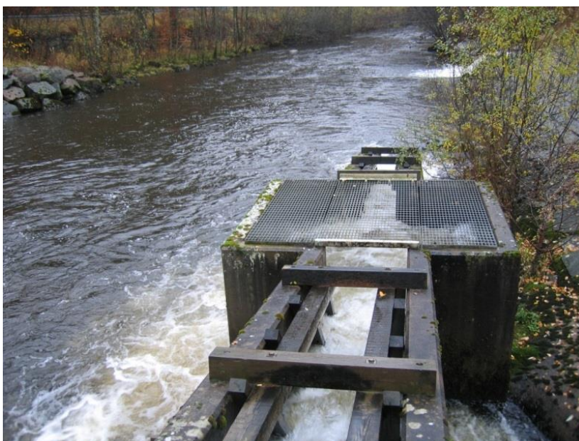
Bild 2. Jonsereds övre fiskväg, en denilränna, erbjuder fisken en vandringsväg förbi dammen som utgör ett definitivt vandringshinder mellan naturfåran vid Jonsereds kraftverk och sjön Aspen. I fiskvägen finns sedan 2005 en automatisk fiskräknare installerad. Foto: Länsstyrelsen i Västra Götaland.
