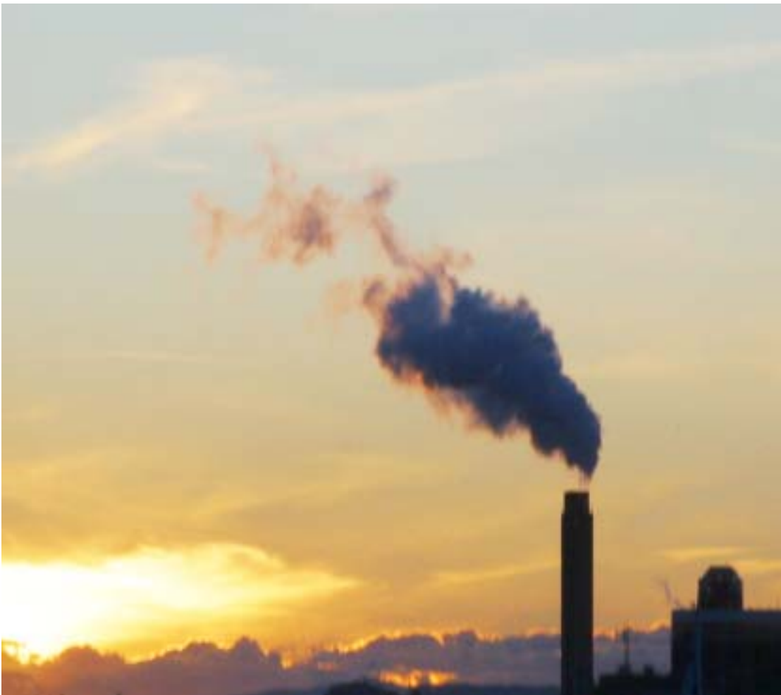
Fjärrvärmeverket i Örebro Foto Länsstyrelsen
