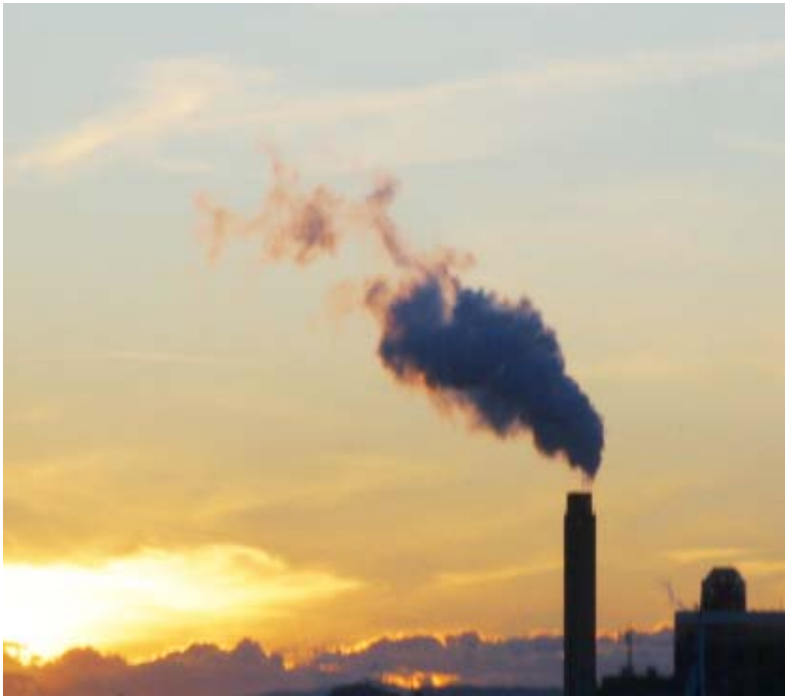
Fjärrvärmeverket i Örebro Foto Länsstyrelsen
