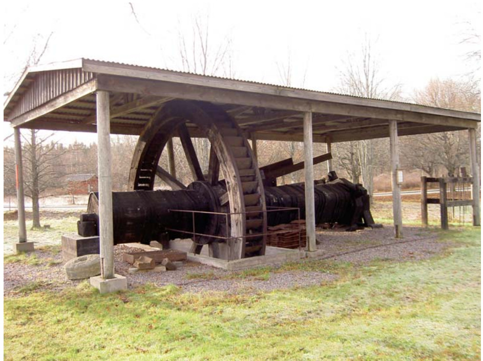
Stångjärnshammare. En s.k. släthammare från smedjan i Svartå. Hammaren togs i bruk 1873 och var i drift fram till slutet av 1930-talet (Foto: Linda Ormann).
