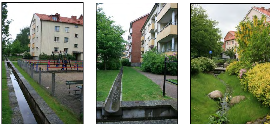
Figur 26. Öppna dagvattensystem i Ekostaden Augustenborg i Malmö (Foto: Ernst Witter).
