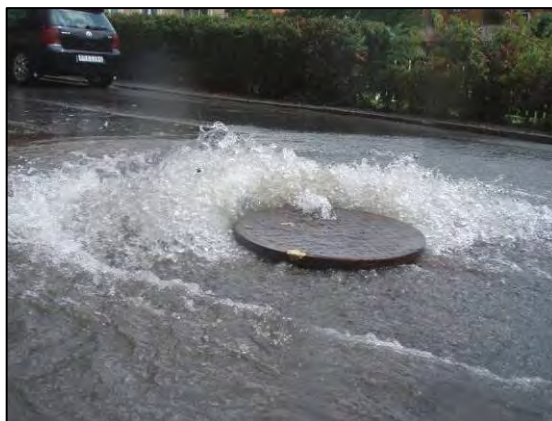
Figur 20. Dagvatten forsar upp av det höga trycket i ledningsnätet (Foto: Jens Råberg).
