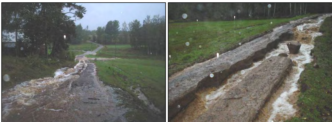
Figur 13. Kraftiga regn spolade bort vägmateriäl i Kvarsätter (Svennevad), augusti 2006 (Foto: Bo Rapp).
