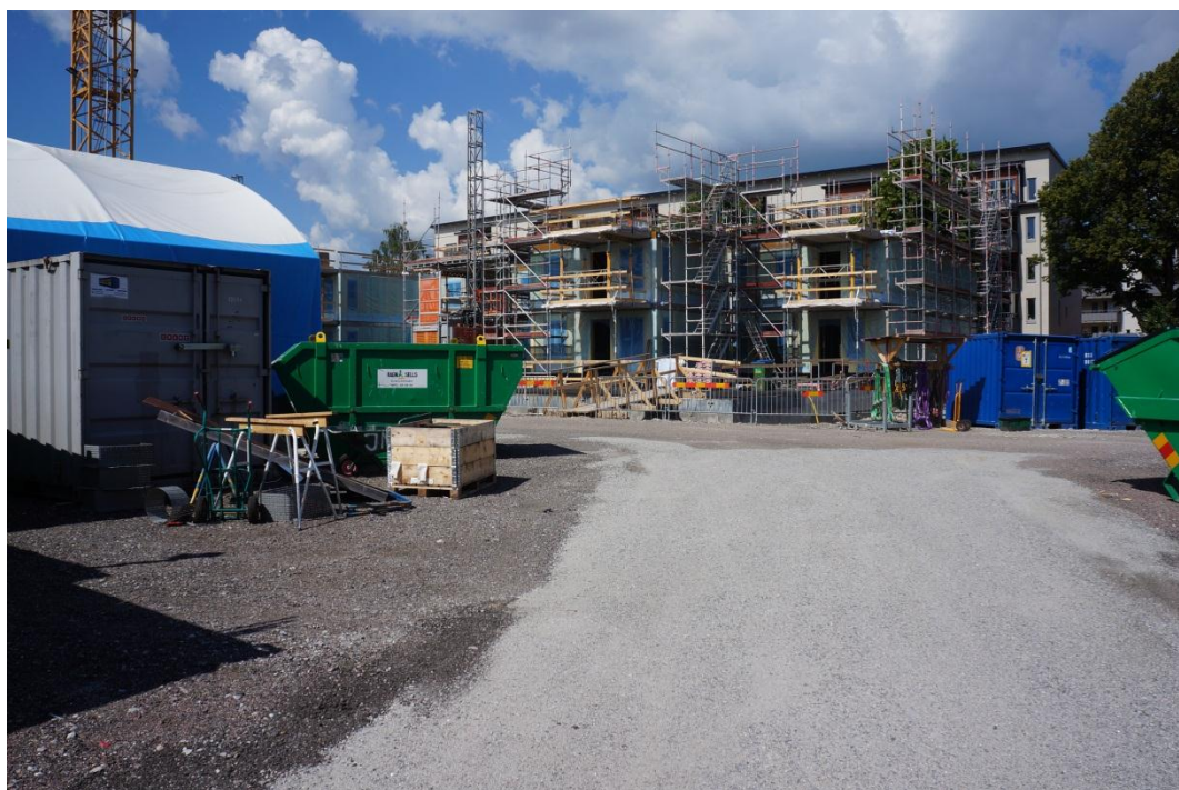
Nybyggnation av bostäder i Rosta, Örebro kommun. Foto: Länsstyrelsen
