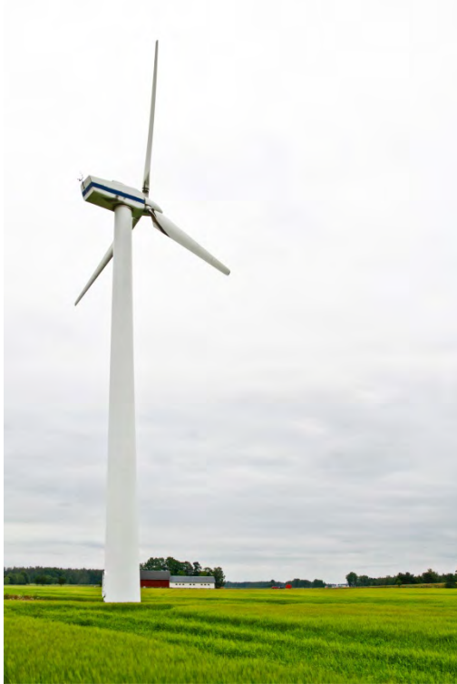
Vindkraftverk utanför Örebro. Foto: Mostphotos
