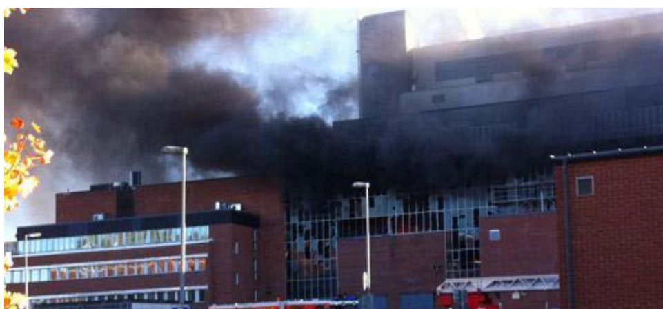
Brand på E.ON Värmeverket 2012. Fotograf: Nerikes Allehanda.
