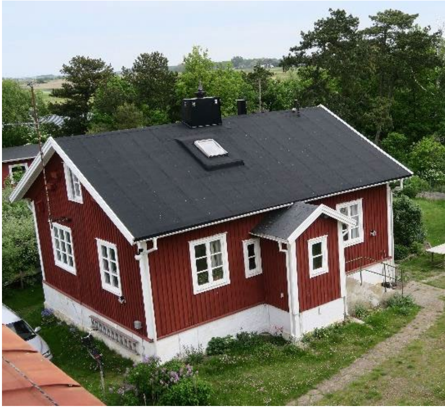
Figur 4 Fyrvaktarebostaden 2021 (Tyréns AB, 2021).
