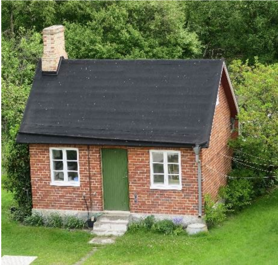
Figur 5 Brygghuset 2021 (Tyréns AB, 2021).
