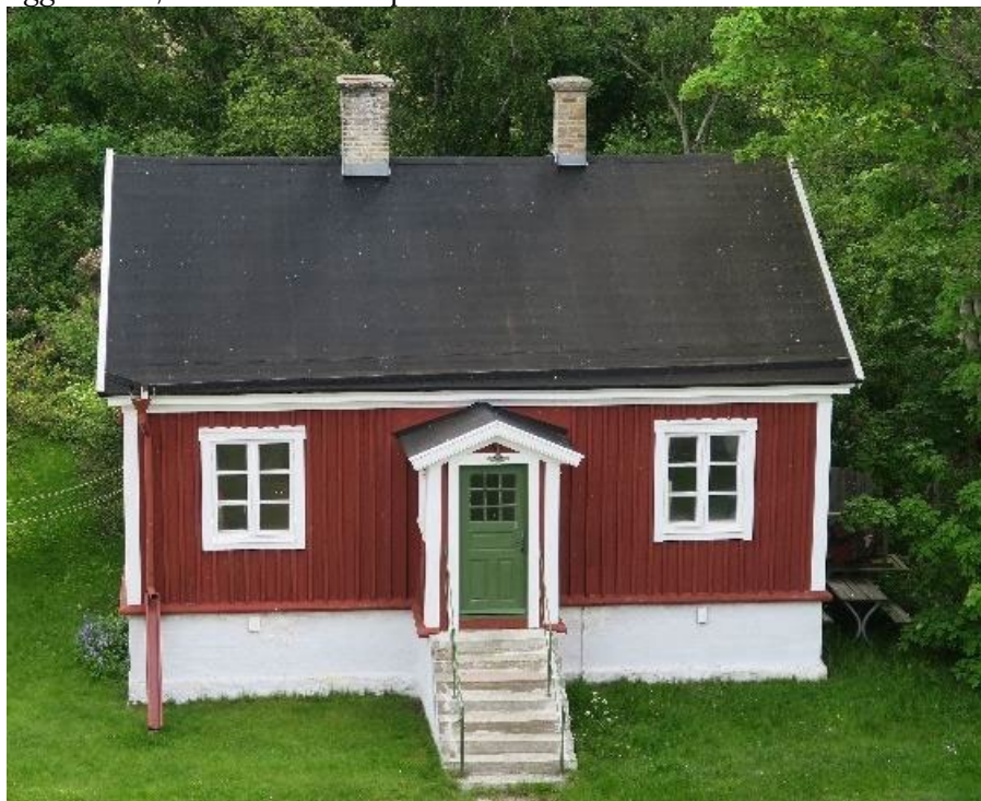
Figur 3 Fyrmästarebostaden 2021 (Tyréns AB, 2021).
